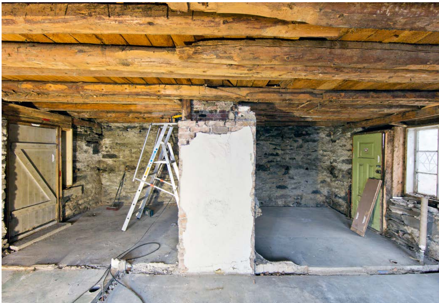
Over: Vegg og pipeløp mot øst. (sett fra vest).
