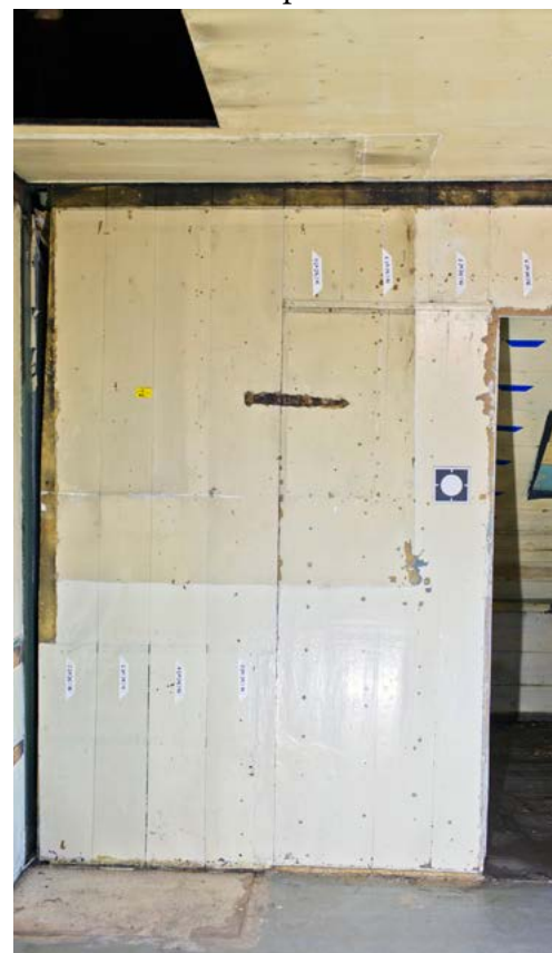
Under til høyre: Kjøkken 302 avdekket. Dør til kott 305 til høyre. Blendet eldre kottdør midt på. Loftsluke over.
