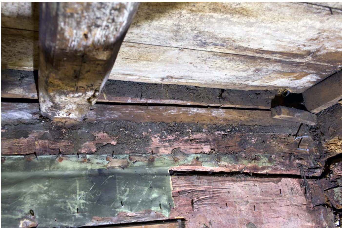
Over: Bjelketilslutning til sydvegg.
