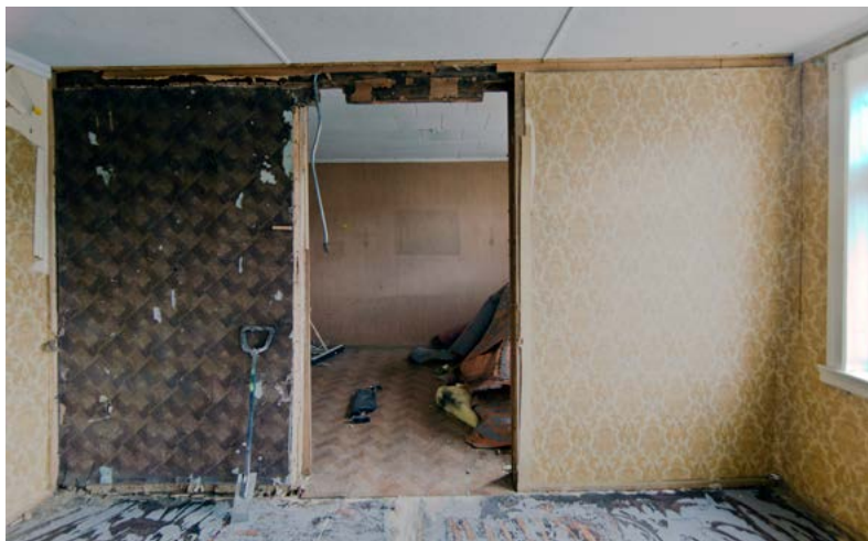
Vegg mot syd
