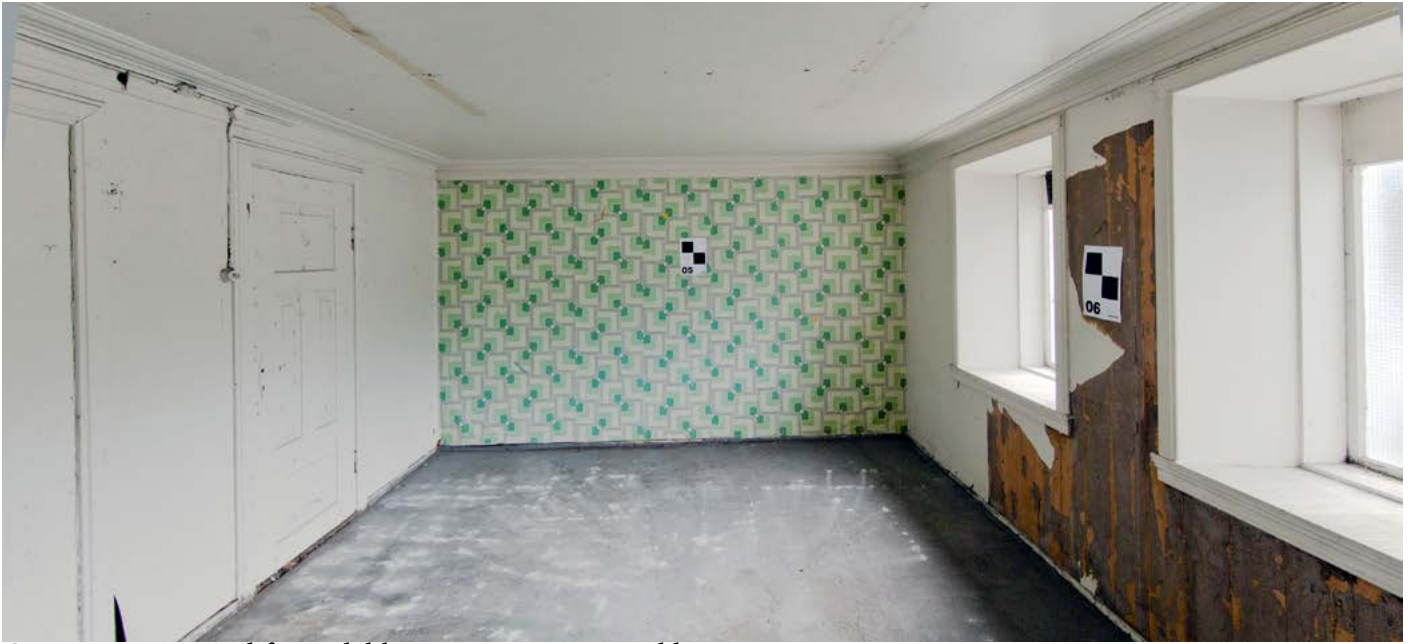
Over: Vegg mot syd før avdekking. Vegg mot vest til høyre.
