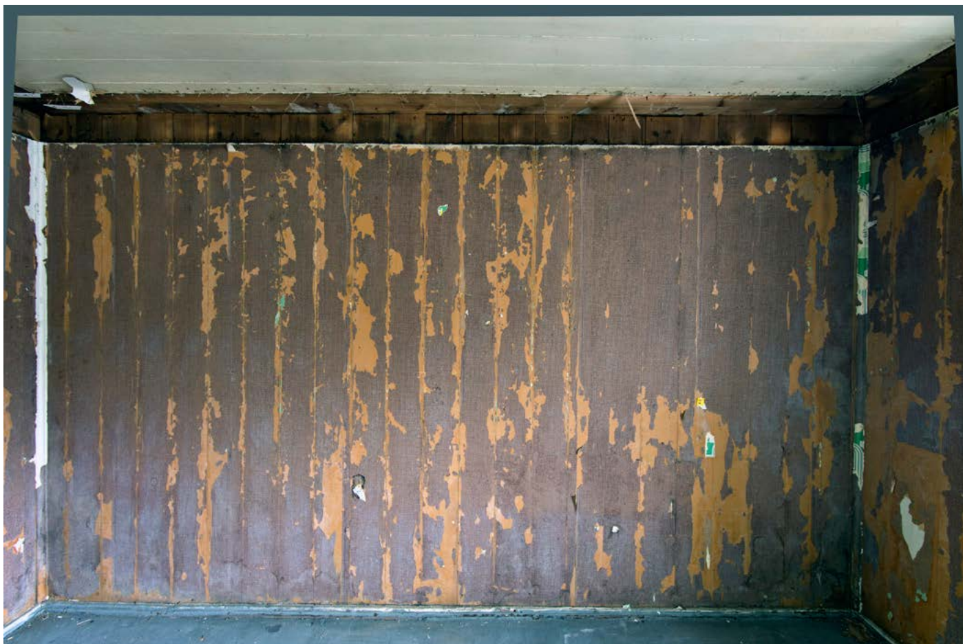
Over: Vegg mot syd etter avdekking.
