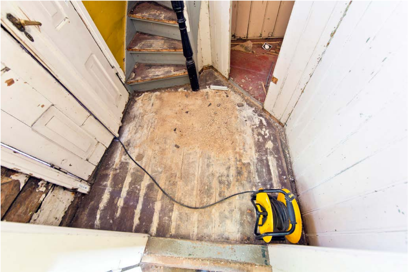
Over: Trapperommets gulv. Ned er mot vest.
