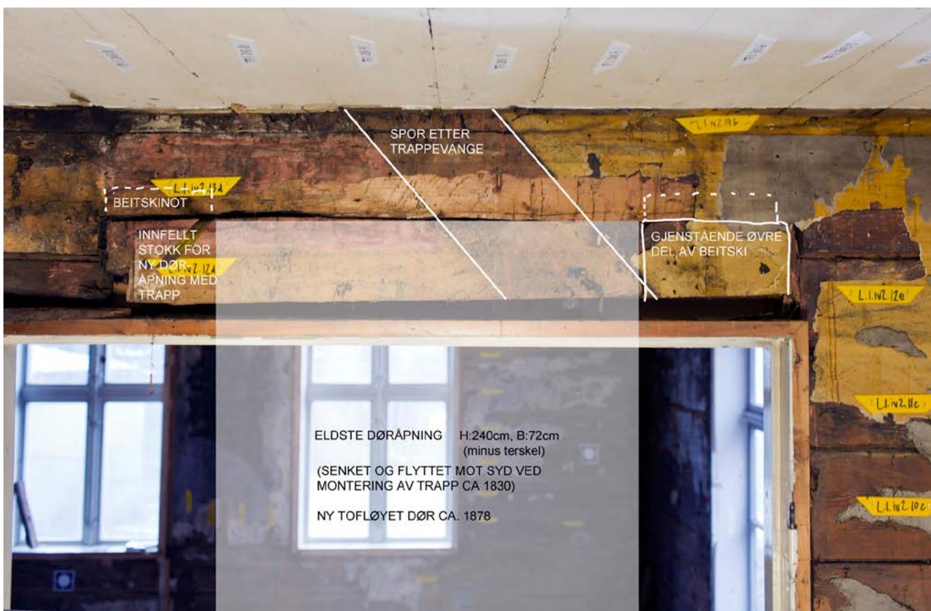
Under: Kjøkken 203, vegg mot stue 204. Spor etter loftstrapp og døråpning mot 204.
