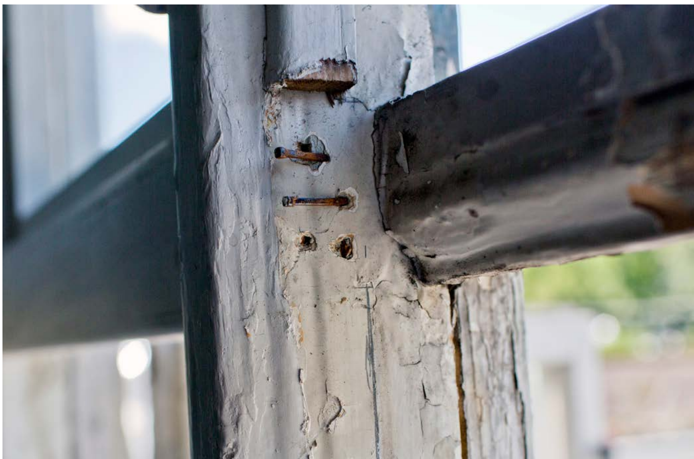
Over: Vindu fra 1830-årene med sekundær midtpostfals i karm. Påslått stykke tre. Under: Profiler og losholt.
