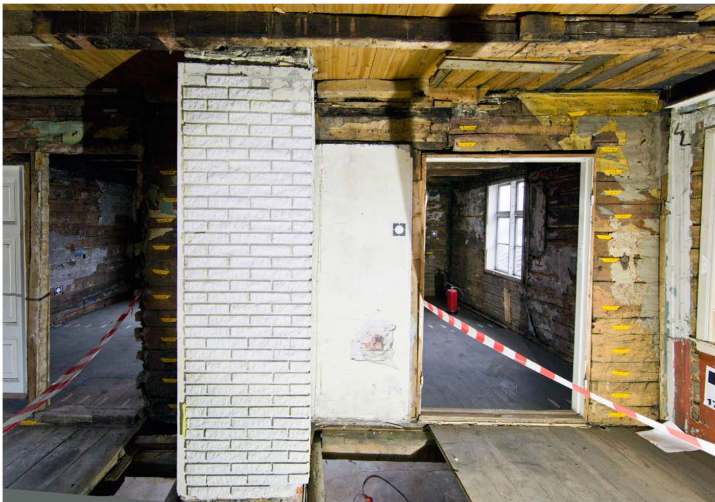
Over: Vestvegg med pipeløp og gulvet delvis åpnet. Kun spor etter gruen i takbjelke.
