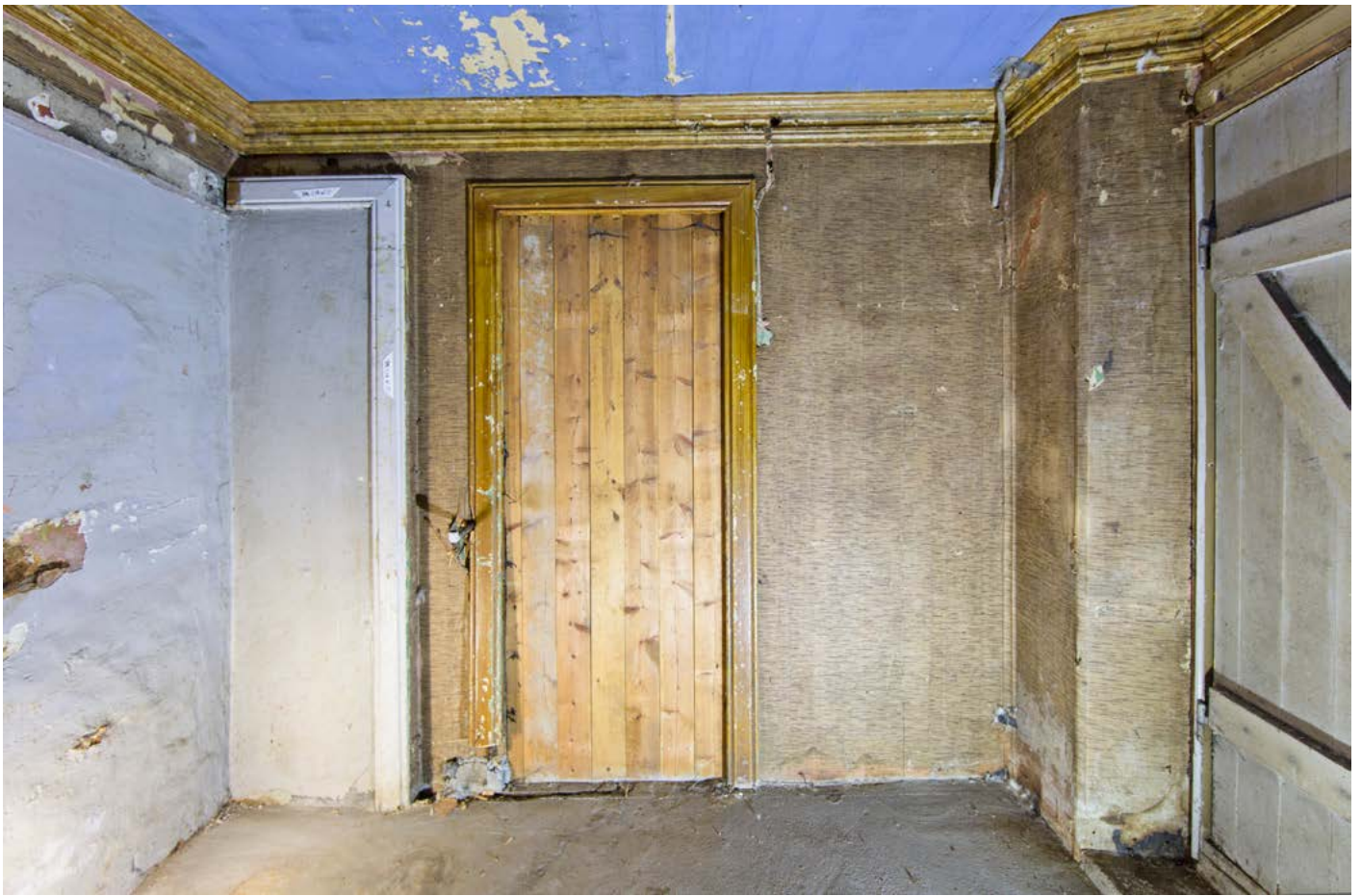
Over: Vegg mot vest. Avdekket. Gjensperret dør mot vest.
