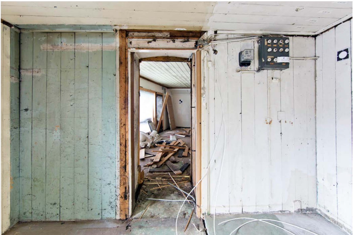
Over: Vegg mot nord med inngang til butikklokale etter avdekking
