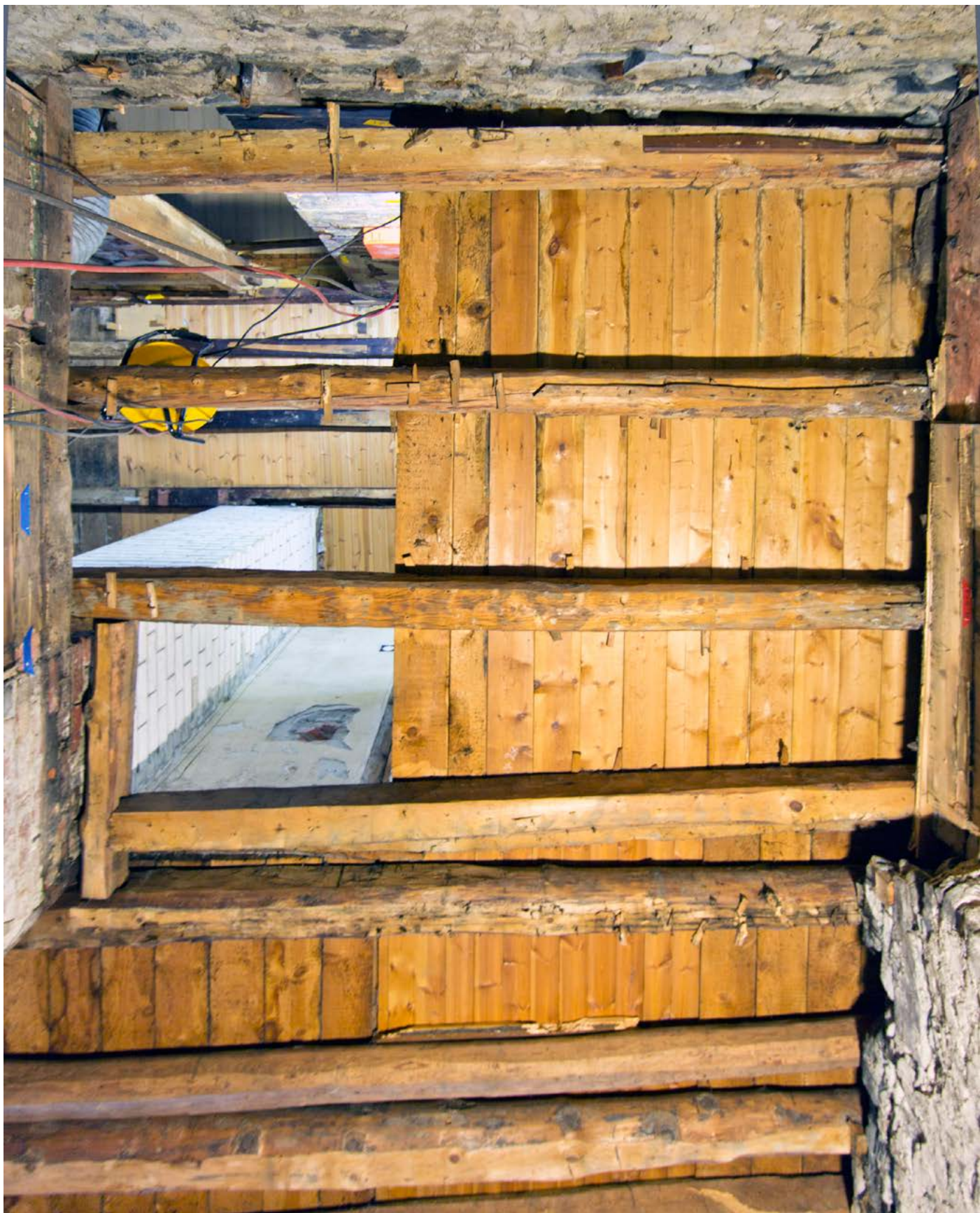
Bjelkelag under nordre del av kjøkken 203.
