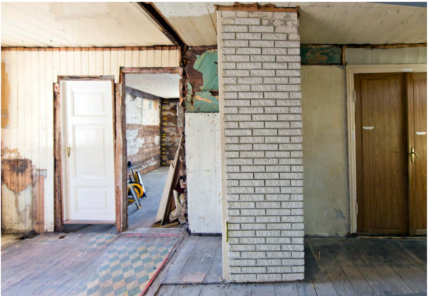
Over: Østvegg på tvers av det opprinnelige romskille mellom kjøkken 203 og kammers 206. Midt på foto sees spor i himling og gulv etter opprinnelig veggskille. Avdekket ådret dør fra 1878 da det opprinnelige kammers 206 fungerte som kjøkken for den da nye påbygde østre leilighet. Under: Tilsvarende perspektiv motsatt vei, mot vest. Opprinnelig veggskille til venstre for pipeløpet.
