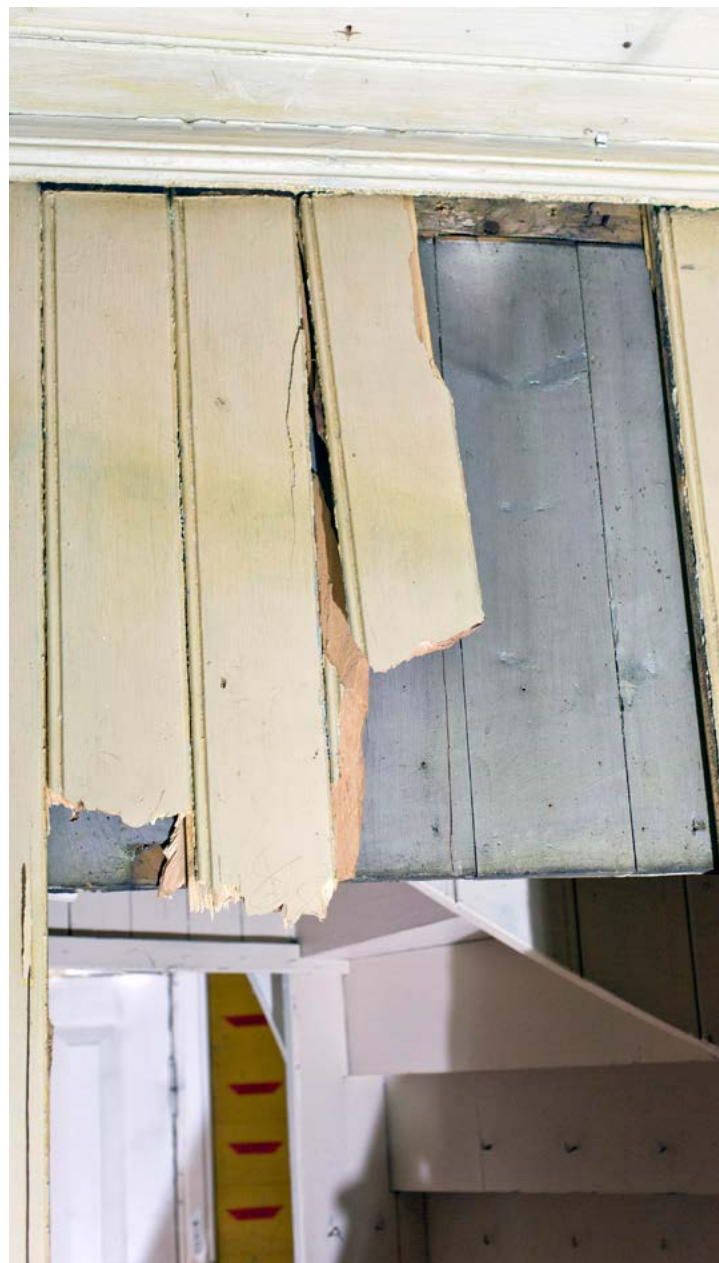
Avdekking av åpning fra 207 til gang/trapp. Perlestaff-panel dekker over pløyd panel (tilhørende perioden med åpning).
