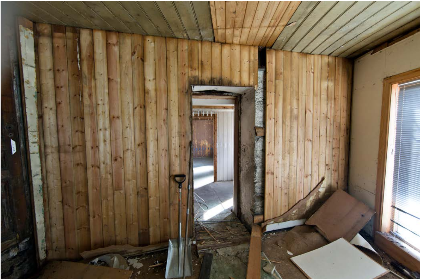
Under: Sydvegg. Avdekket. Pløyd panel over opprinnelig pusset naturstensgrunnmur hovedhus.
