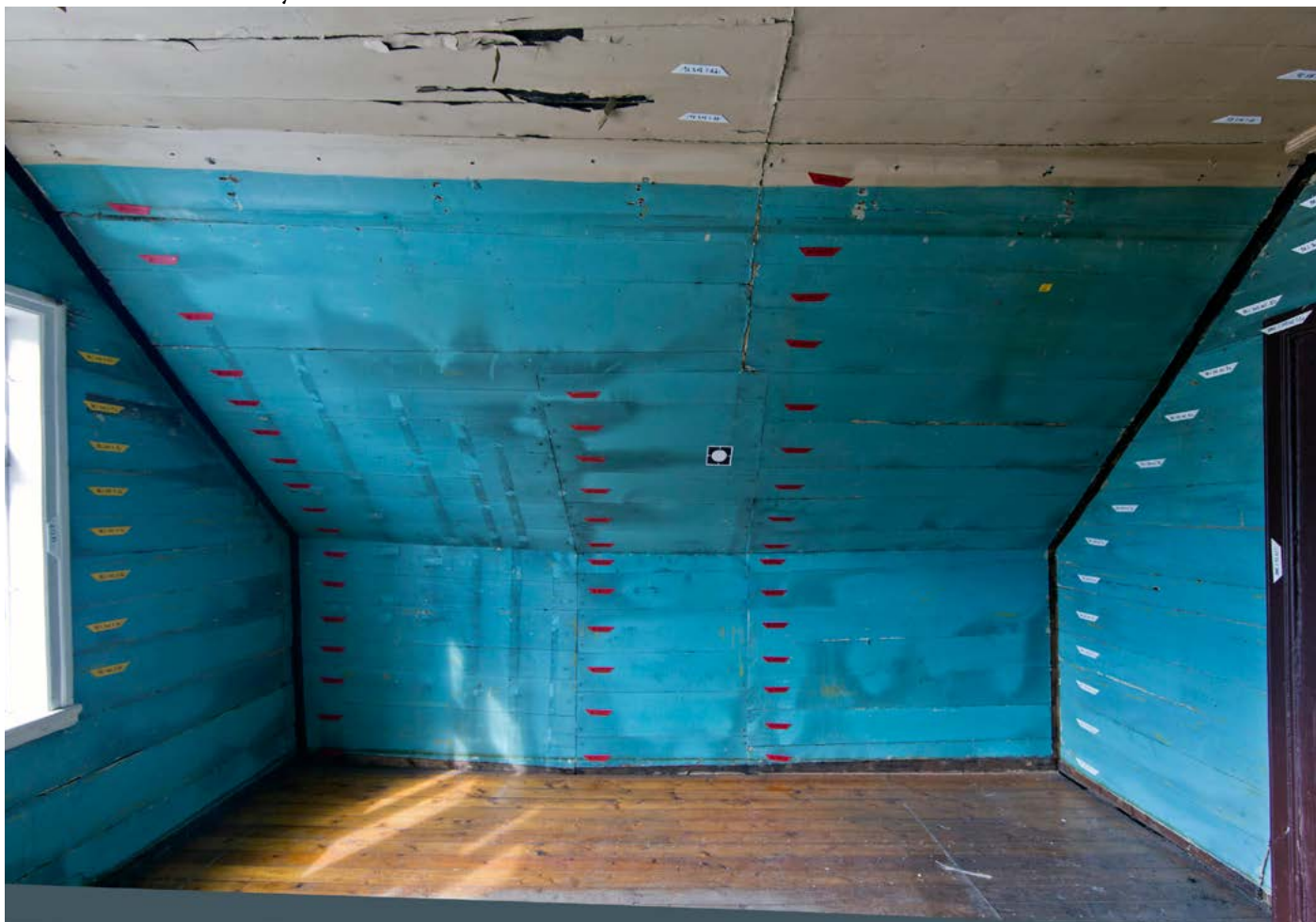
Under: Avdekket. Fra syd mot nord.
