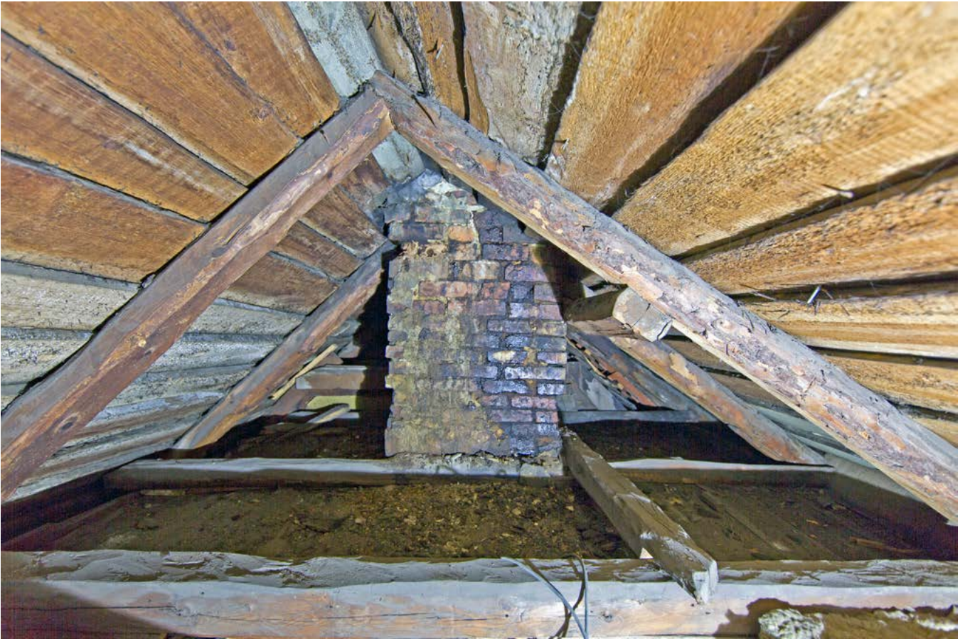
Over: Midtre loft med pipeløp. Opprinnelig.
