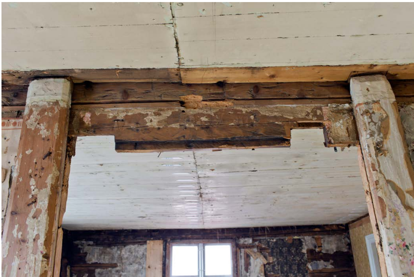
Over: Spor etter døråpninger. Nordvegg.
