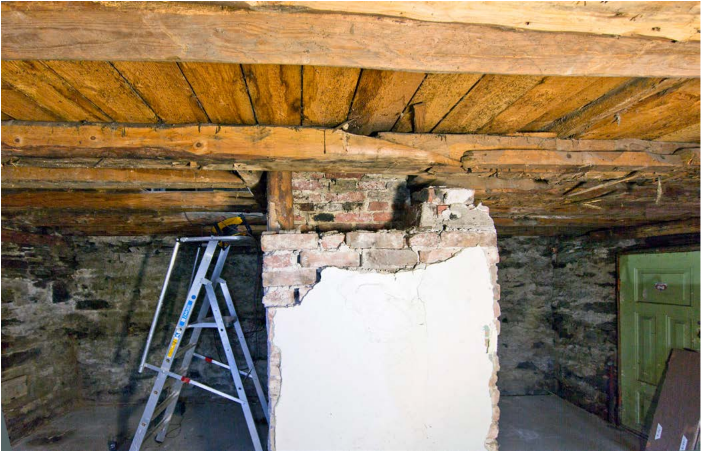
Over og under: Brannmur og bakenforliggende pipeløp sett mot øst fra syd. Pipeløpet inneholder eldre type sten enn brannmuren. Antagelig gjenbrukt etter nedrivning av grue med fundament for oppbygging av ny pipe med brannmurer til tilstøtende nyinnredede kjellerrom.
