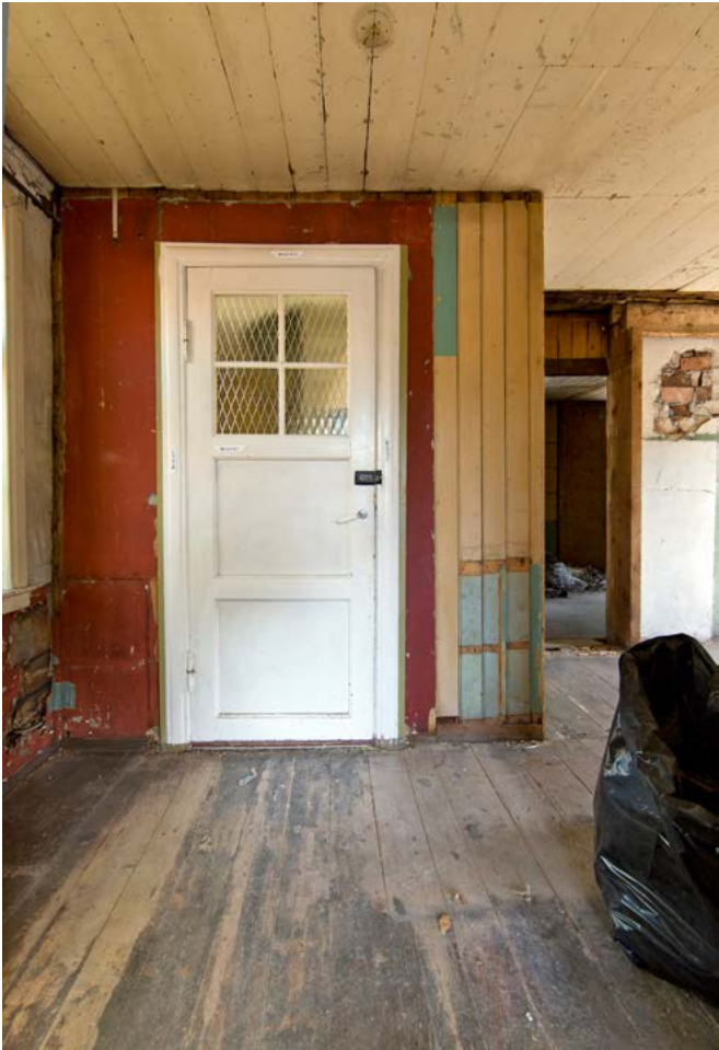
Over: Gjenstående lettvegg mot øst med dør til trapperom. Kledninger, belegg og plater fjernet. Under: Perspektiv fra nordvagg mot sydvegg.
