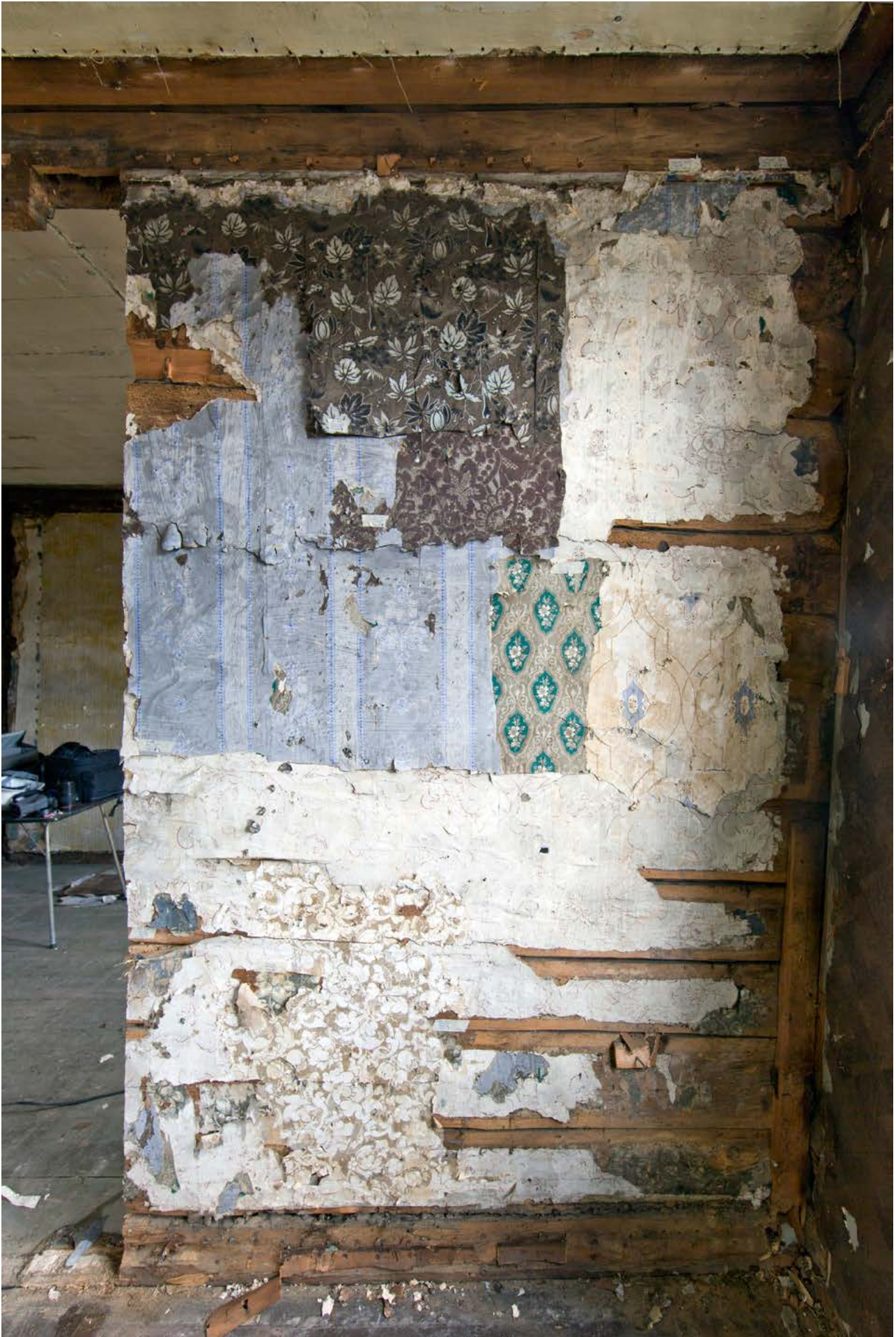
Vegg mot syd, vestre del, avdekket.
