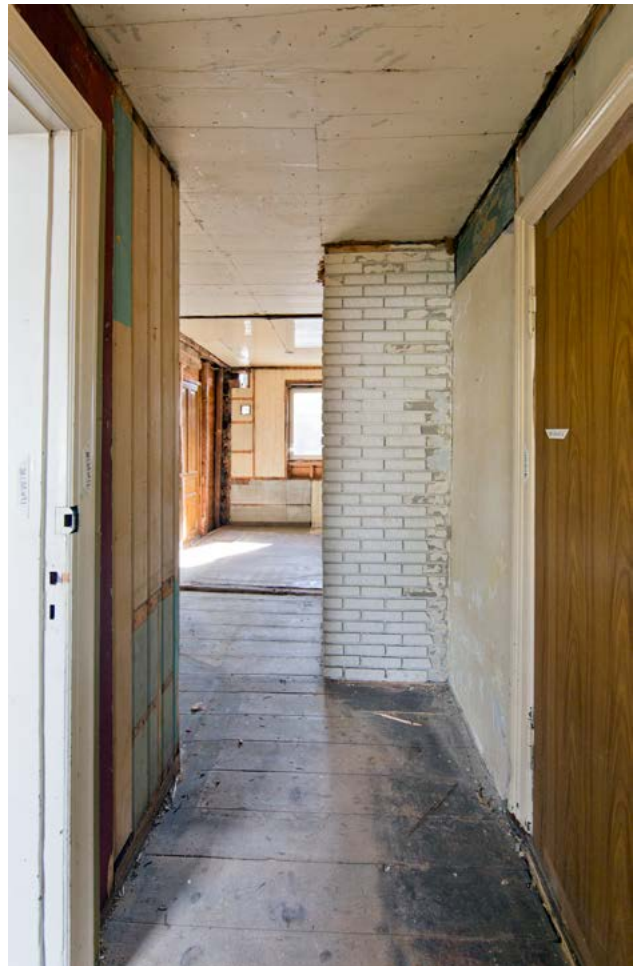
Over: Mot nord. Vindu antagelig 1920/30-tall. Under: Samme perspektiv som under til venstre etter fjerning av sekundære overflater himling/gulv.
