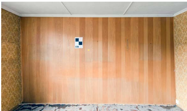
Vegg mot nord
