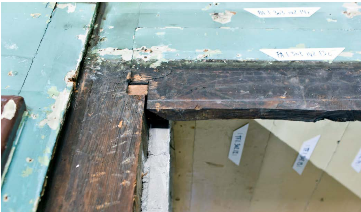
Over: Døråpning anno 1830-årene mot 302. Opprinnelig overflate (umalt, men sotet) bevart bak sveitssergrikt anno 1878.
