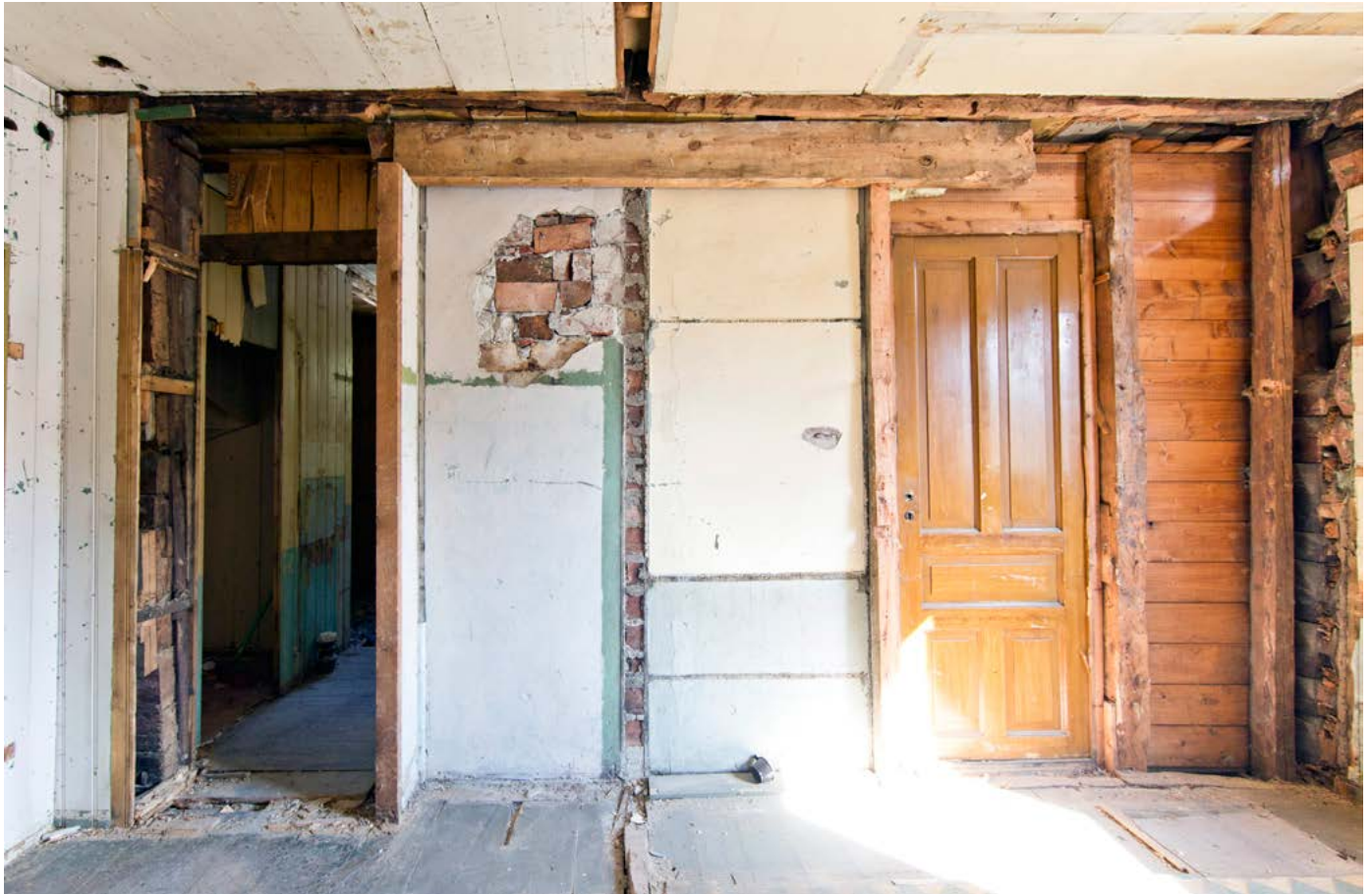
Over: Østvegg på tvers av det opprinnelige romskille mellom kjøkken 203 og kammers 206. Midt på foto sees spor i himling og gulv etter opprinnelig veggskille. Avdekket ådret dør fra 1878 da det opprinnelige kammers 206 fungerte som kjøkken for den da nye påbygde østre leilighet. Under: Tilsvarende perspektiv motsatt vei, mot vest. Opprinnelig veggskille til venstre for pipeløpet.
