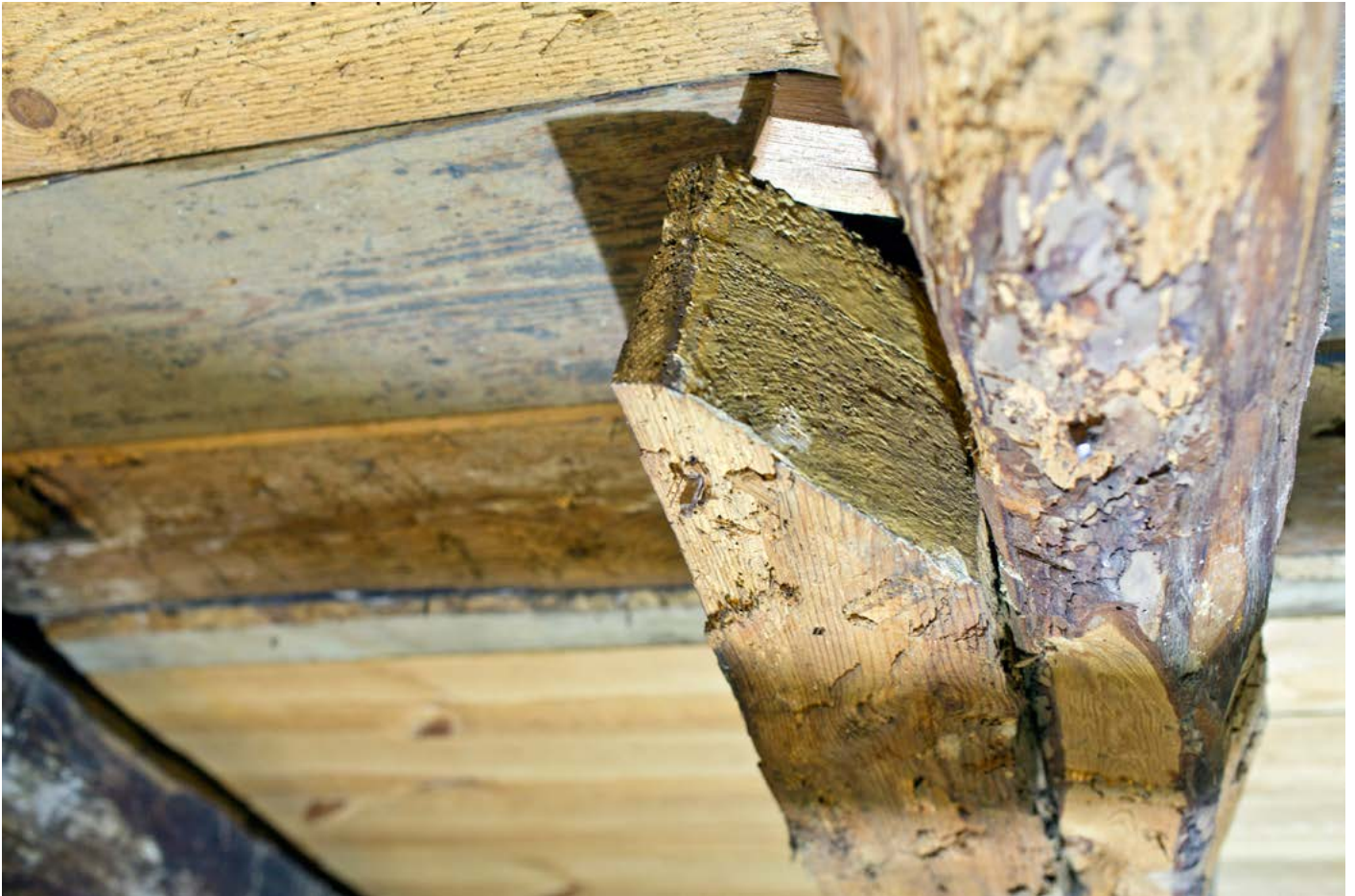
Over: Nærfoto av malt faset bjelkeende opprinnelig åpen mot trappeåpning.
