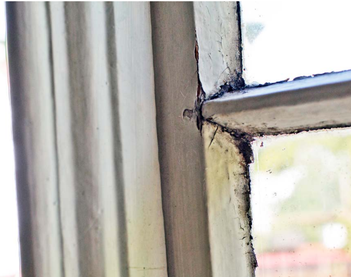
Vindusdetaljer vindu mot øst. Opprinnelig haspe og midtpost med tidsriktige profiler.
