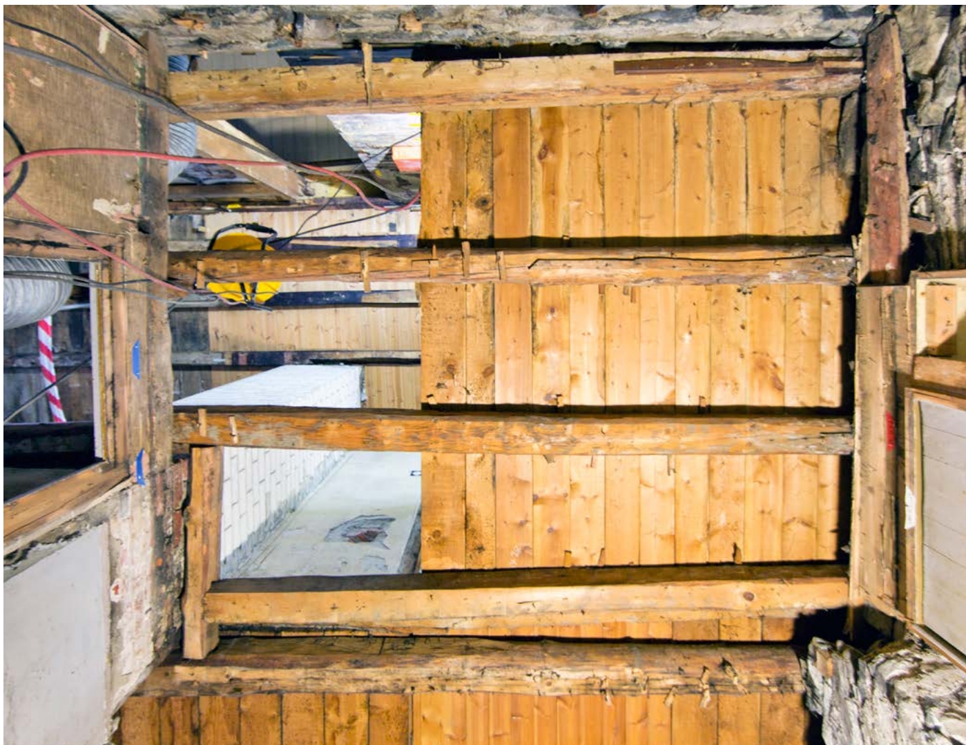
Bjelkelag under nordre del av kjøkken.
