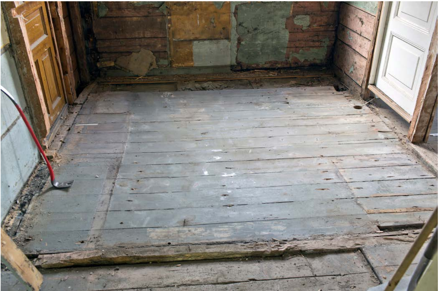
Under: Gulvet sett fra nord mot syd. I forgrunnen rest av nedre omfar tømmer i fjernet vegg.
