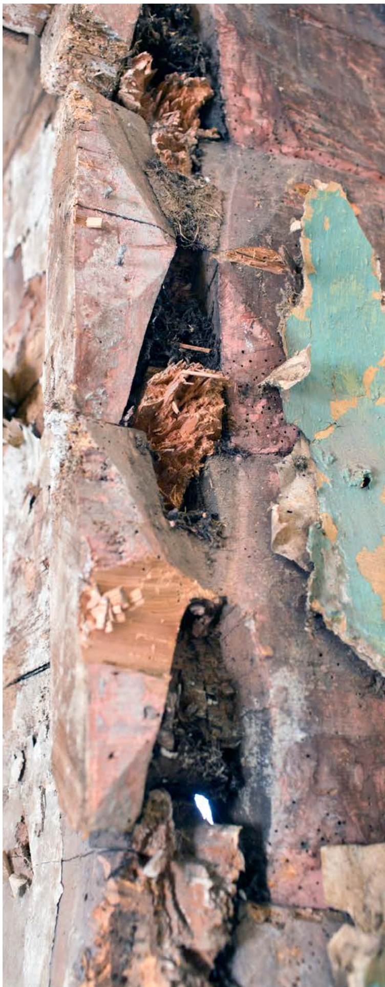
Avdekket laft på vestvegg. Knutepunkt til kjøkken og stuer. Fint utført 1700-tallslaft. Midtre del av 1700-tallet?
