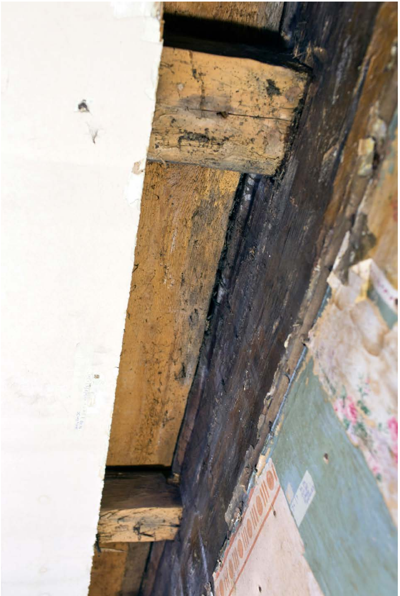
Takbjelketilslutning til vegg syd.
