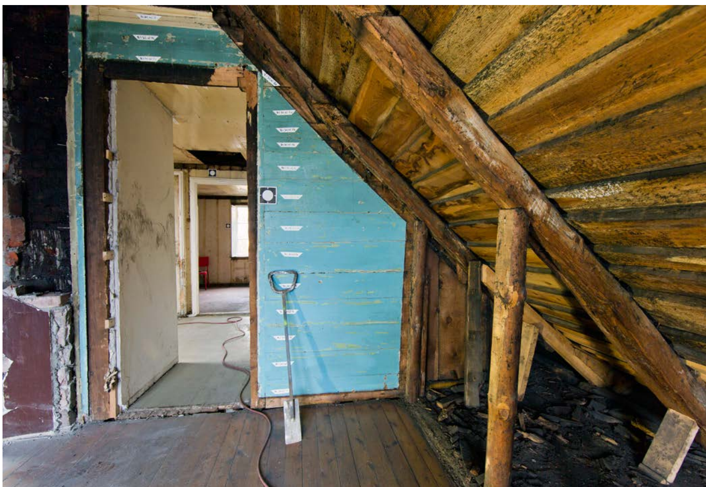
Under: Søndre del av lettveggen.
