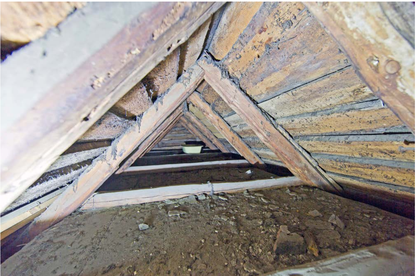
Under: Loft mot vest. Opprinnelig.
