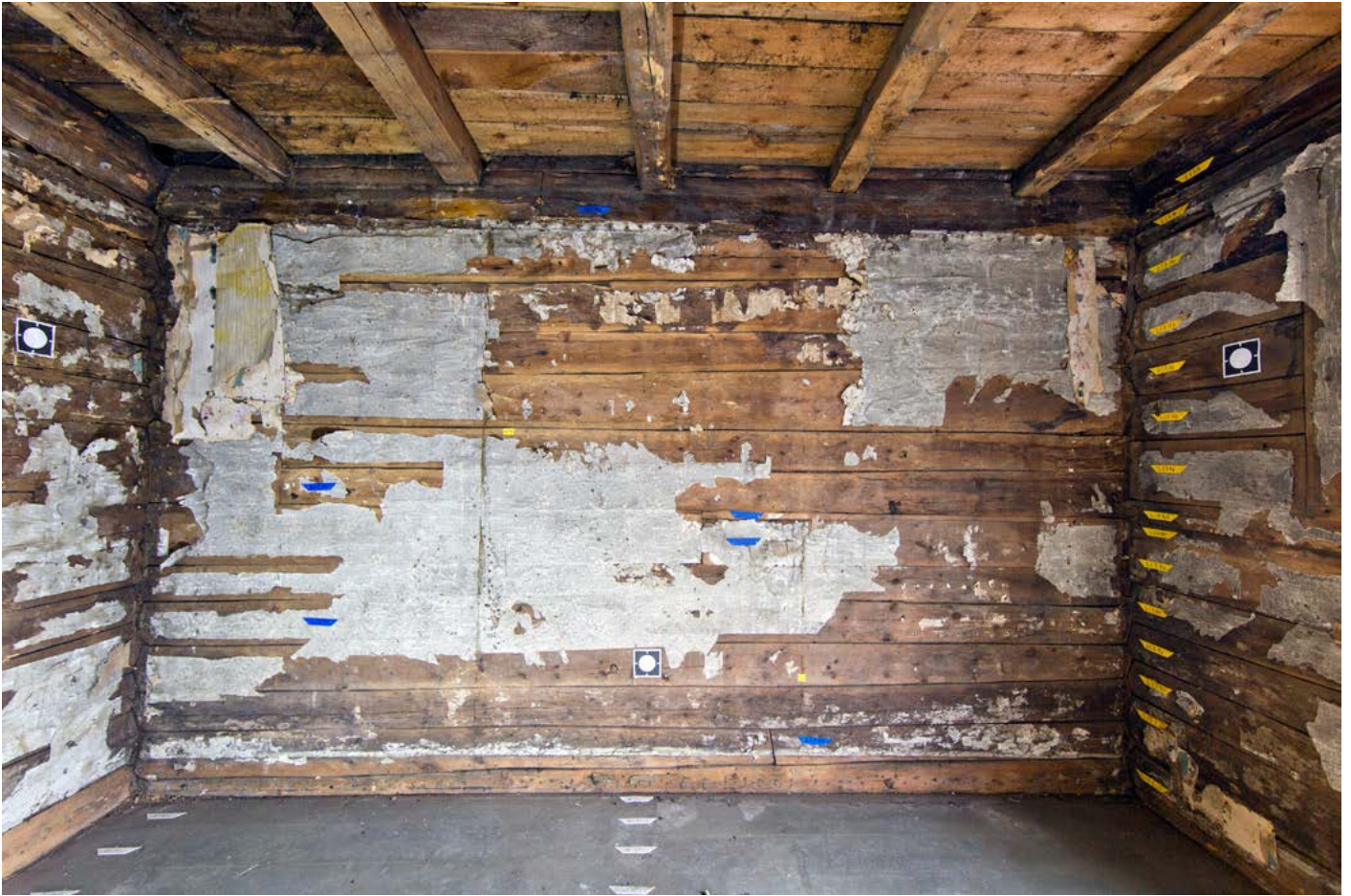
Over: Sydvegg. Mye tapet fjernet for innsyn til tømmer.
