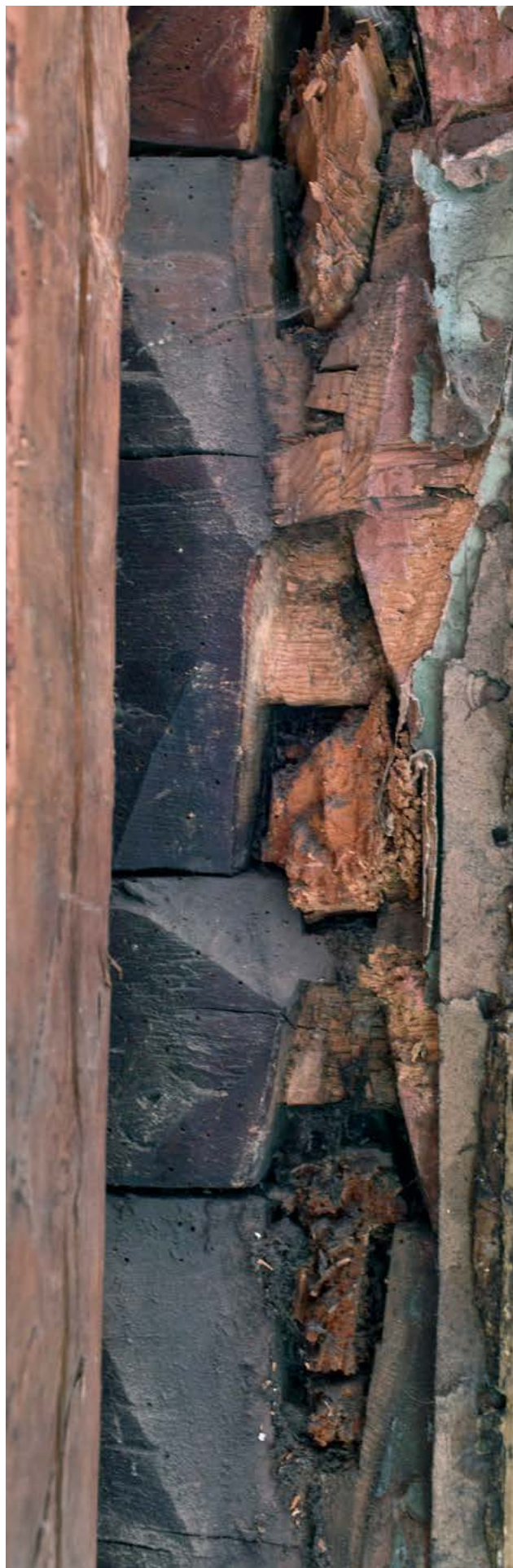
Avdekket laft på vestvegg. Knutepunkt til kjøkken og stuer. Fint utført 1700-tallslaft. Midtre del av 1700-tallet?
