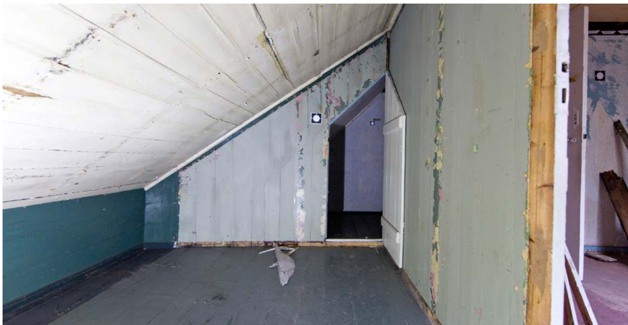
Under: Mot vest og sekundær inngang til kott 305 etter avdekking.
