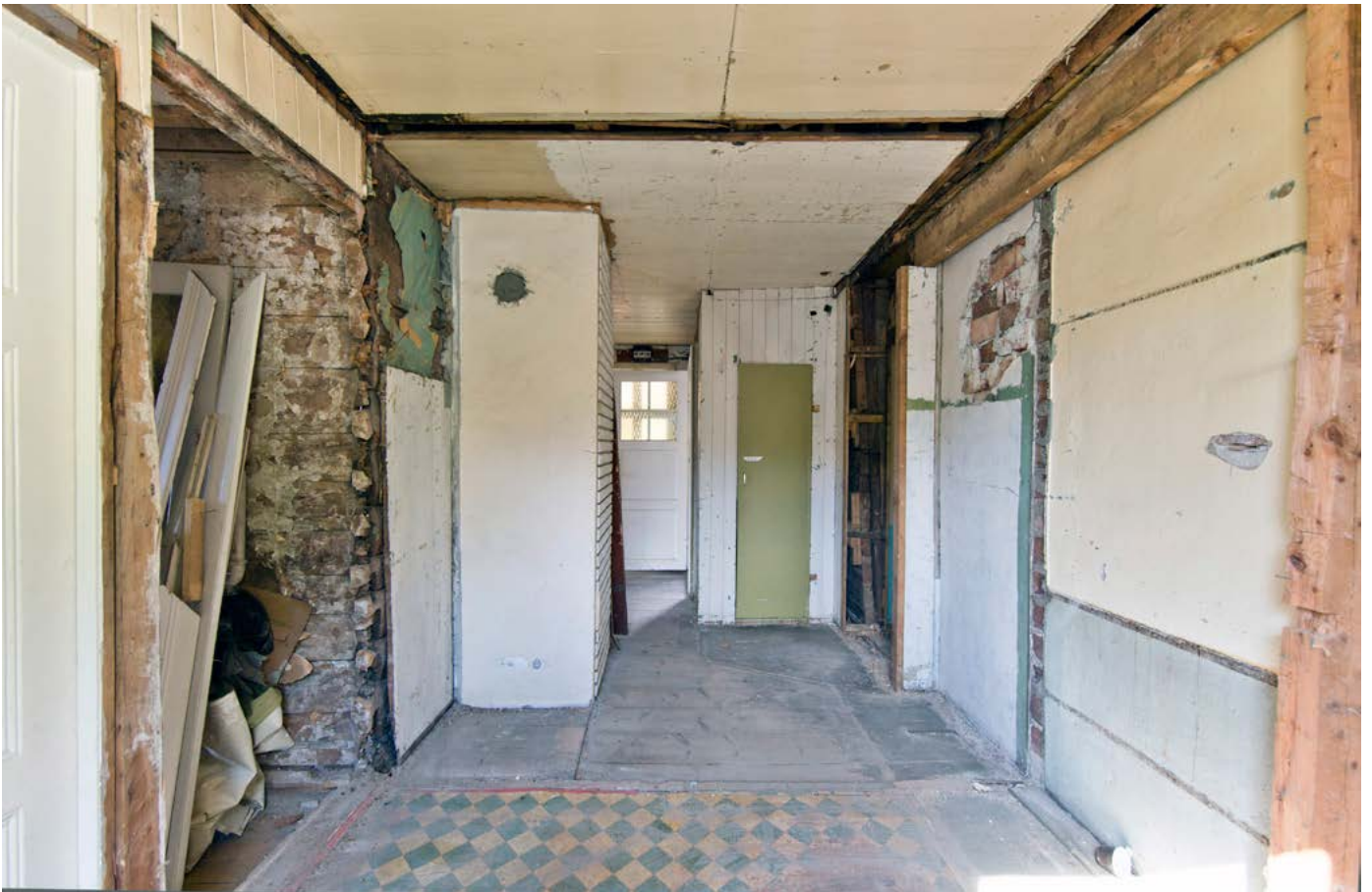
Under: Mot nord. Opprinnelig tømmervegg saget ned. Spor i gulv og himling samt oversaget laft på vestvegg. Mot øst er det meste av tømmerveggen fjernet.
