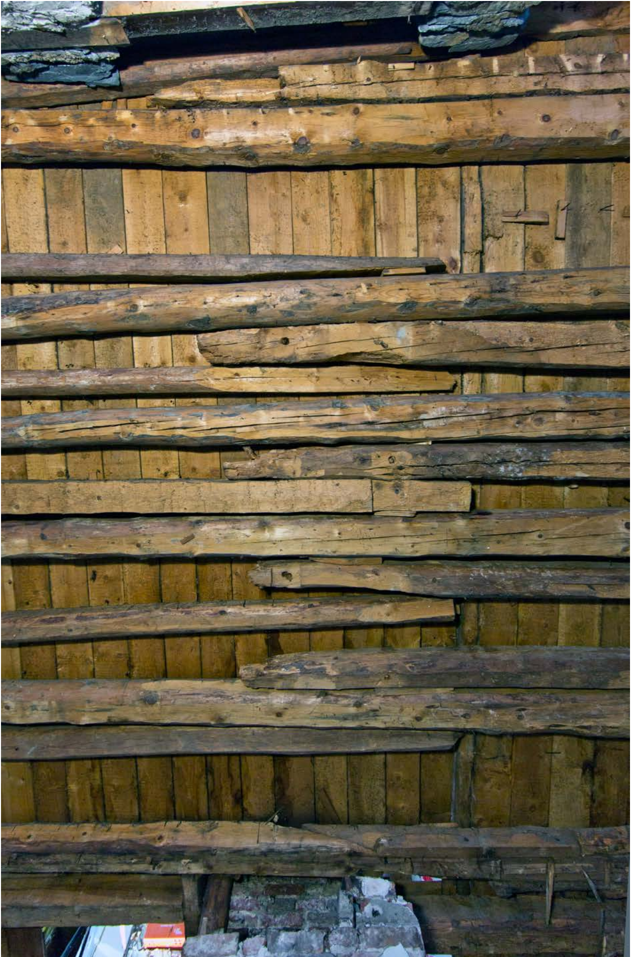
Midtre del av bjelkelaget mot stuene 204 og 205. Det er sannsynlig at en lettvegg som avdelte kjelleren i to seksjoner har stått her (I øst-vest retning).
