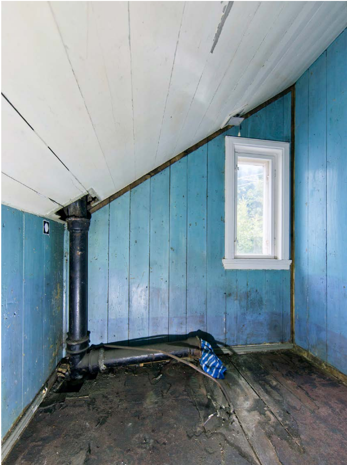
Antagelig innredet i 1878 ved påbygningen. Antagelig opprinnelig vindu med gerikter. Senere innredet til toalett.
