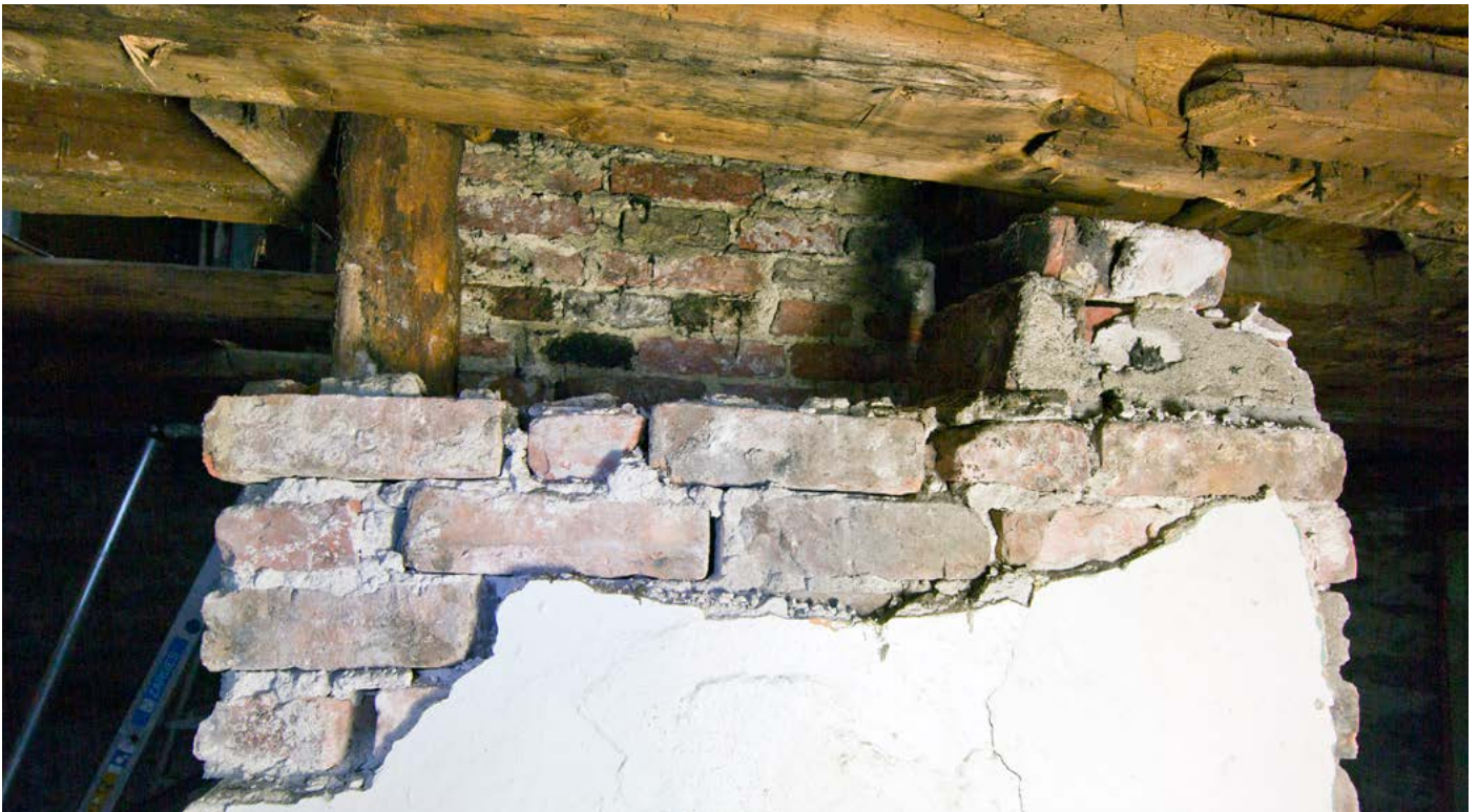
Over og under: Brannmur og bakenforliggende pipeløp sett mot øst fra syd. Pipeløpet inneholder eldre type sten enn brannmuren. Antagelig gjenbrukt etter nedrivning av grue med fundament for oppbygging av ny pipe med brannmurer til tilstøtende nyinnredede kjellerrom.
