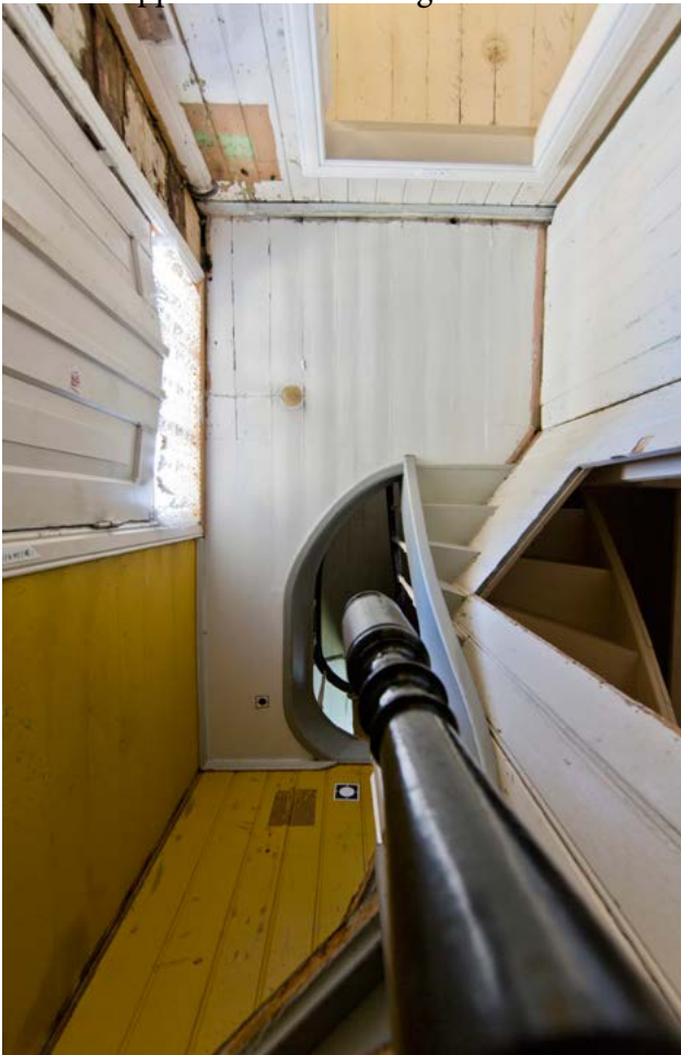
Under: Trapperommets himling. Ned er øst.
