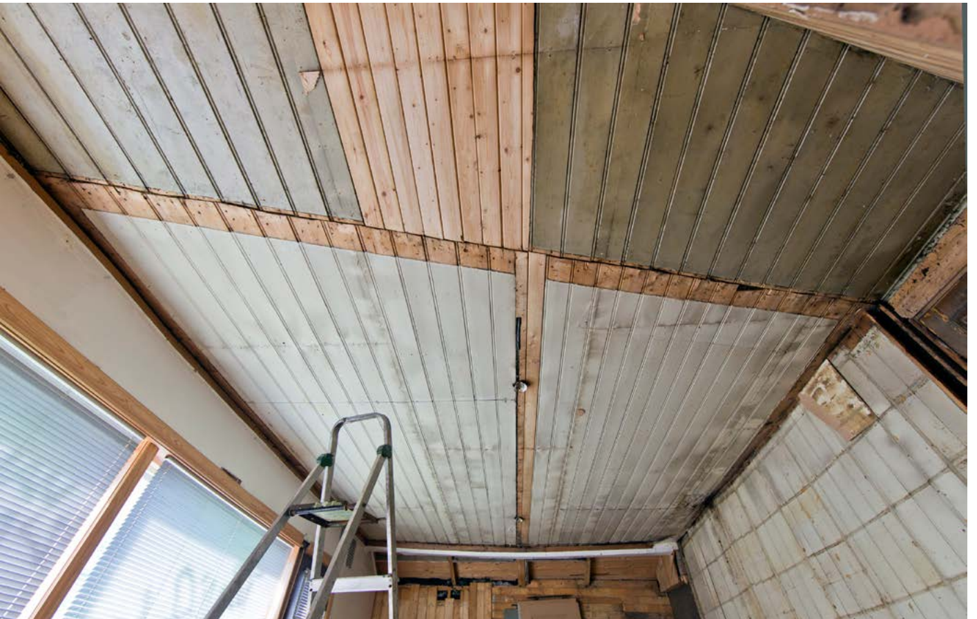
Under: Himling fra syd mot nord. Avdekket.
