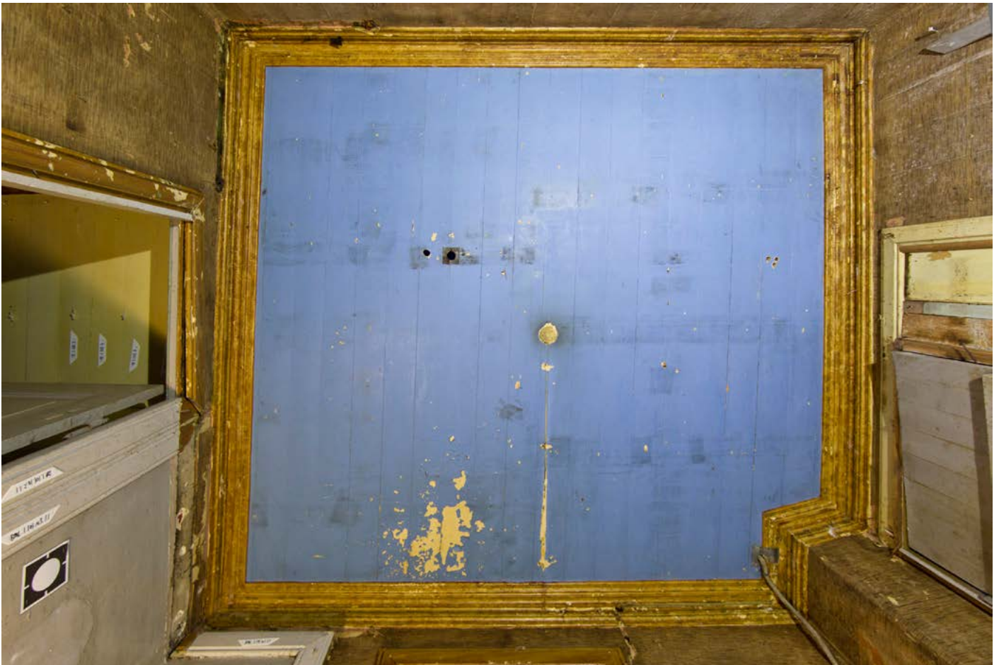
Over: Mot syd. Etterkrigs platekledninger. Under: Himling avkledd. Bordhimling og listverk anno 1878.
