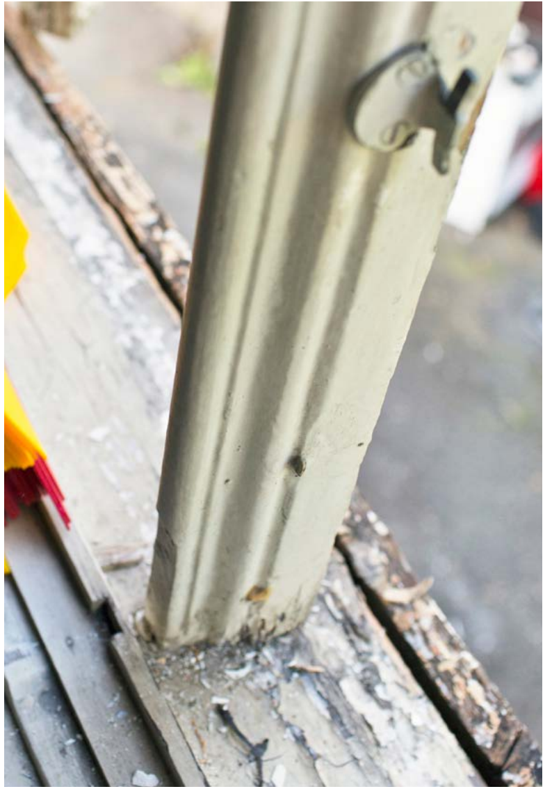
Vindusdetaljer vindu mot øst. Opprinnelig haspe og midtpost med tidsriktige profiler.
