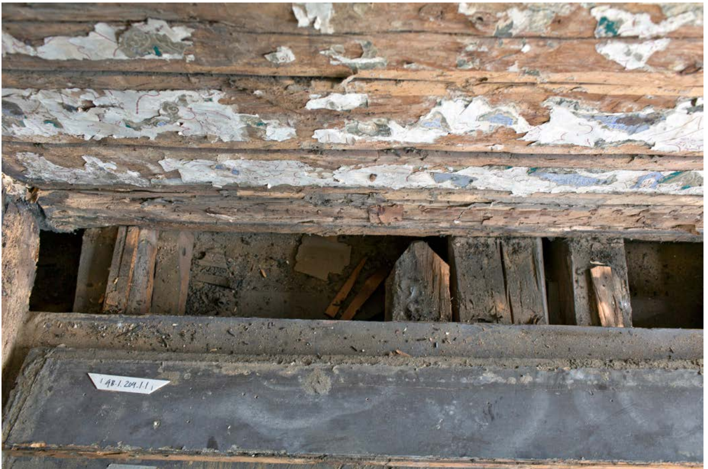
Gulvbjelkelag mot nordvegg. Eldre eller opprinnelige gulvbjelker er forsterket med nye bjelker.
