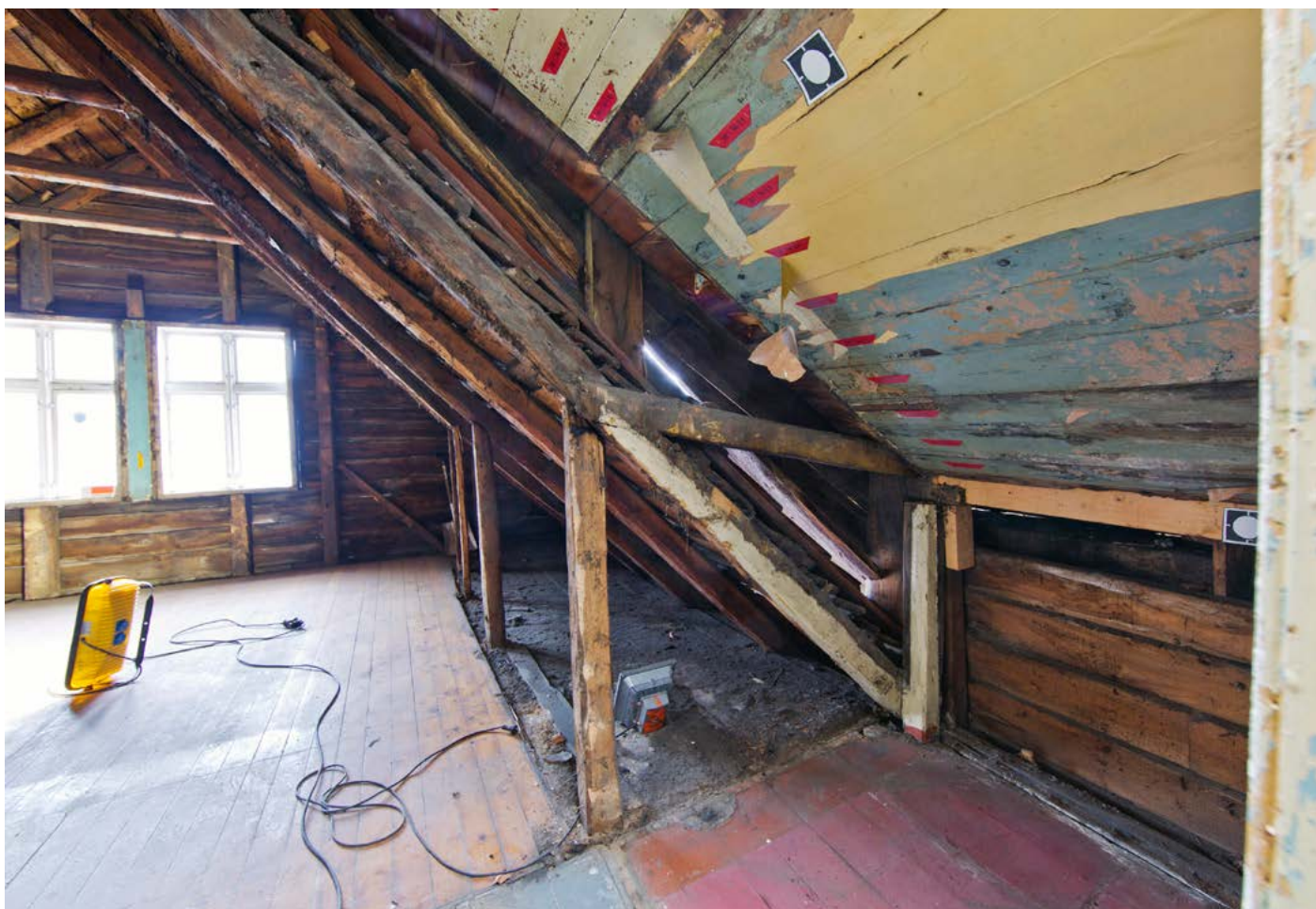
Over: Veggskillet mellom gavlværelset og østre loft besto kun av lettvegg av liggende pløyde bord.
