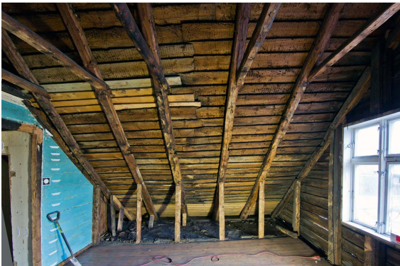
Over: Konstruksjon og undertak mot syd.
