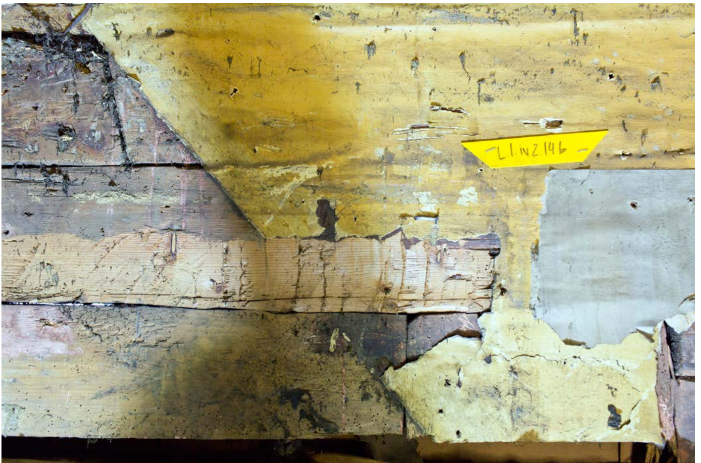
Under: Spor etter trappens vange/vinkel mot vestvegg.
