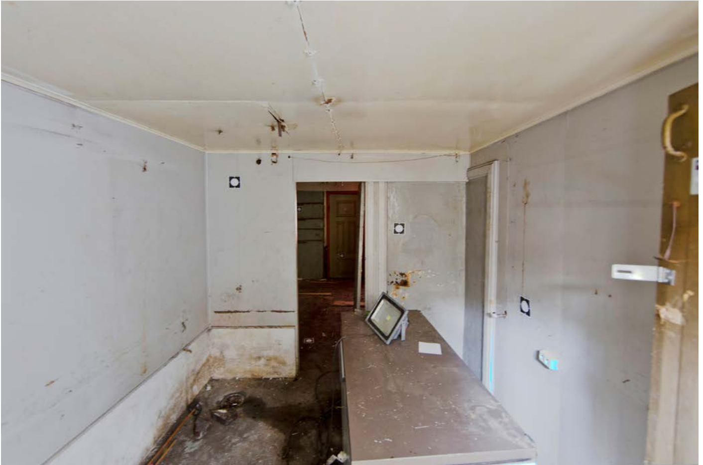
Over: Mot syd. Etterkrigs platekledninger. Under: Himling avkledd. Bordhimling og listverk anno 1878.
