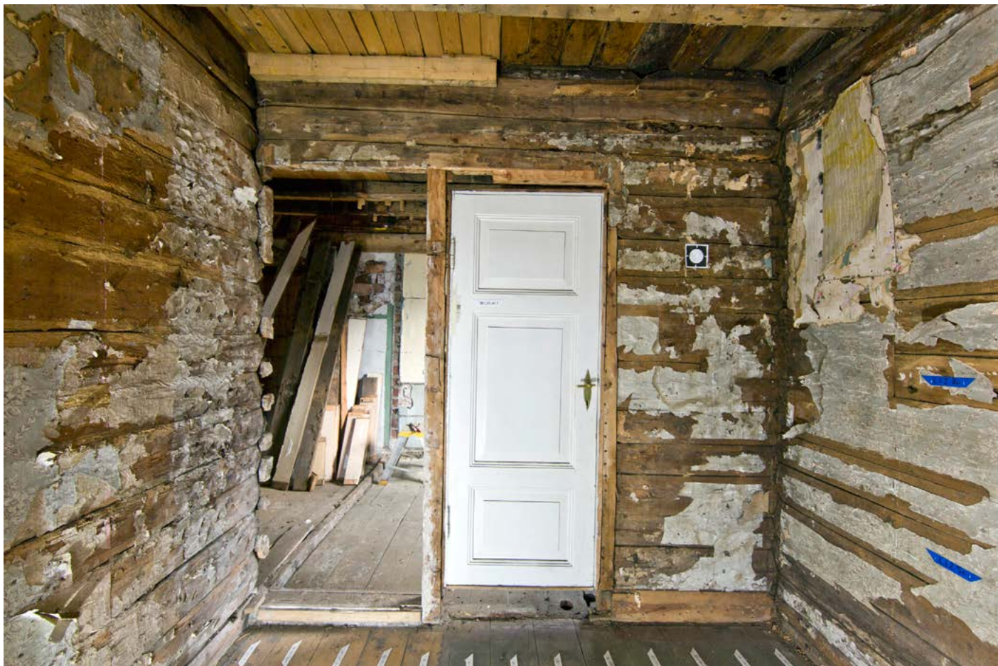
Under: Østvegg. Bevart loftskammersgulv anno 1830-årene i ytterkaqnt under skråtak. Ellers etterkrigs gulv over bjelkene.
