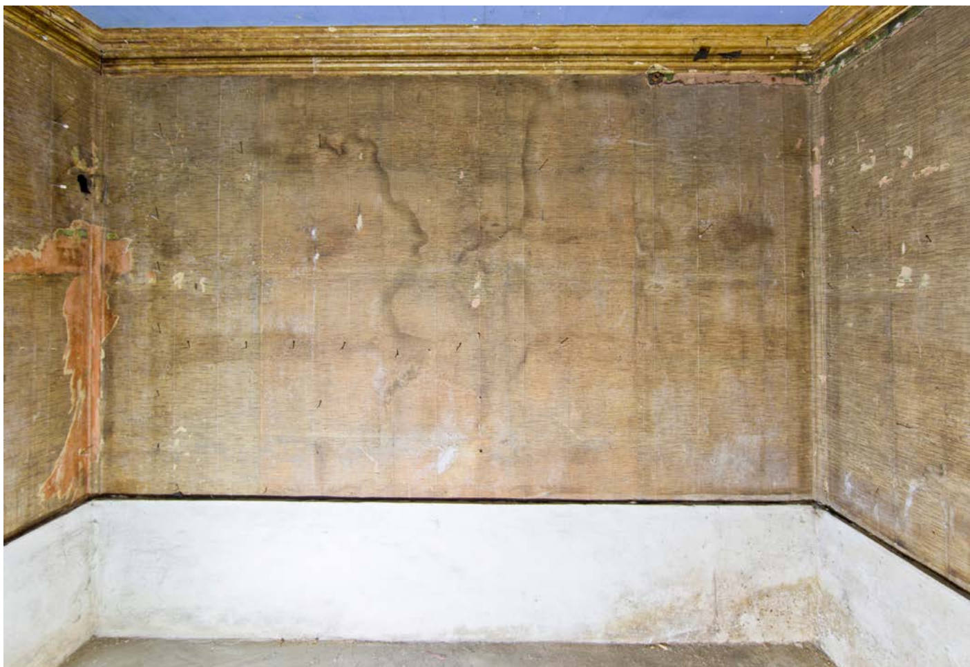
Under: Vegg mot øst. Avdekket til 1878. Yngre støpt mur.
