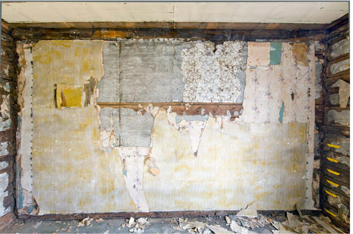
Over: Sydvegg med komplette tapetrester.
