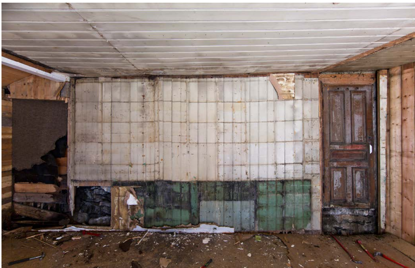
Under: Østveggen mot skrenten. Avdekket.
