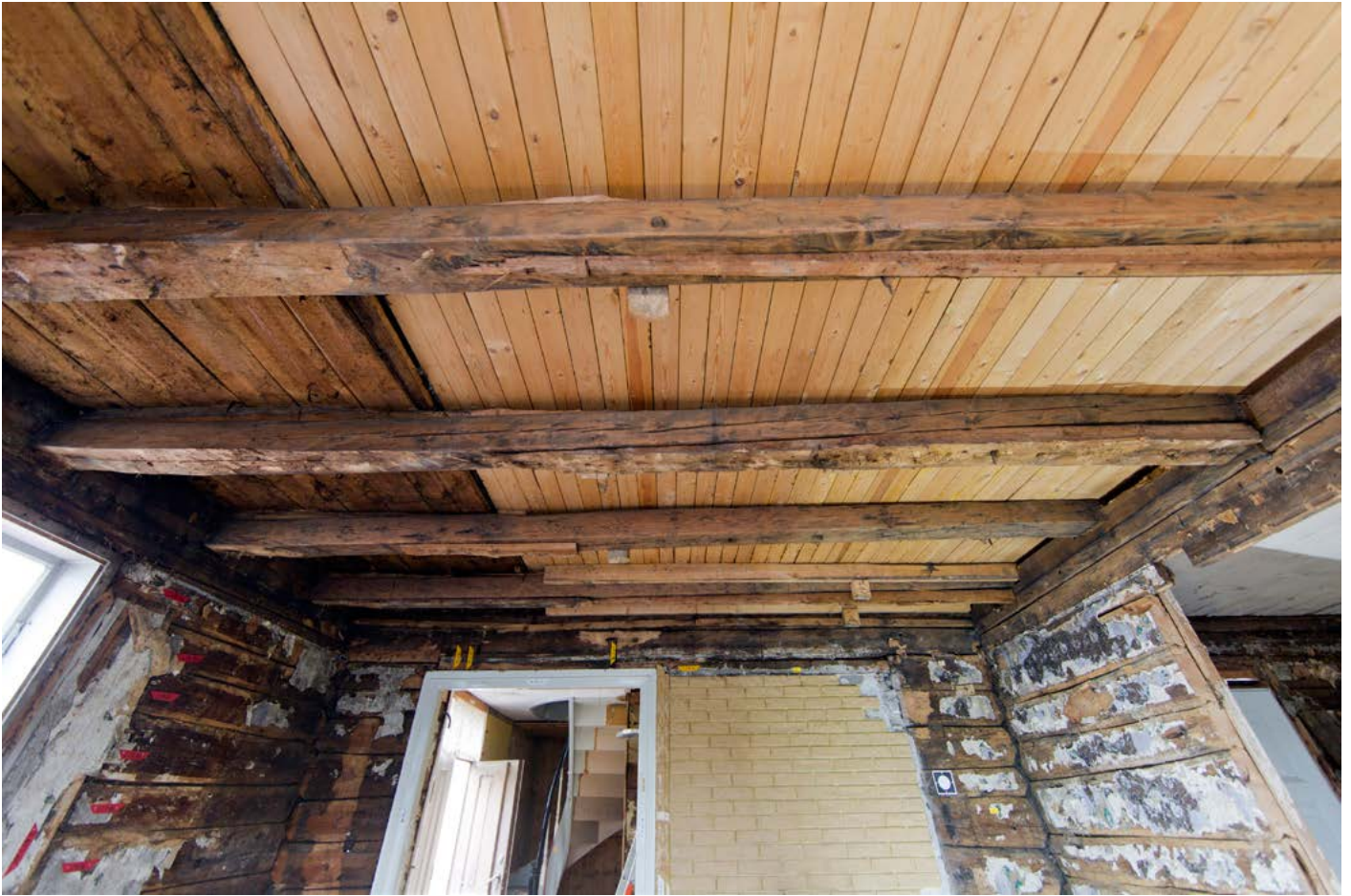
Over: Bjelkehimlingen sett fra vest mot øst.
