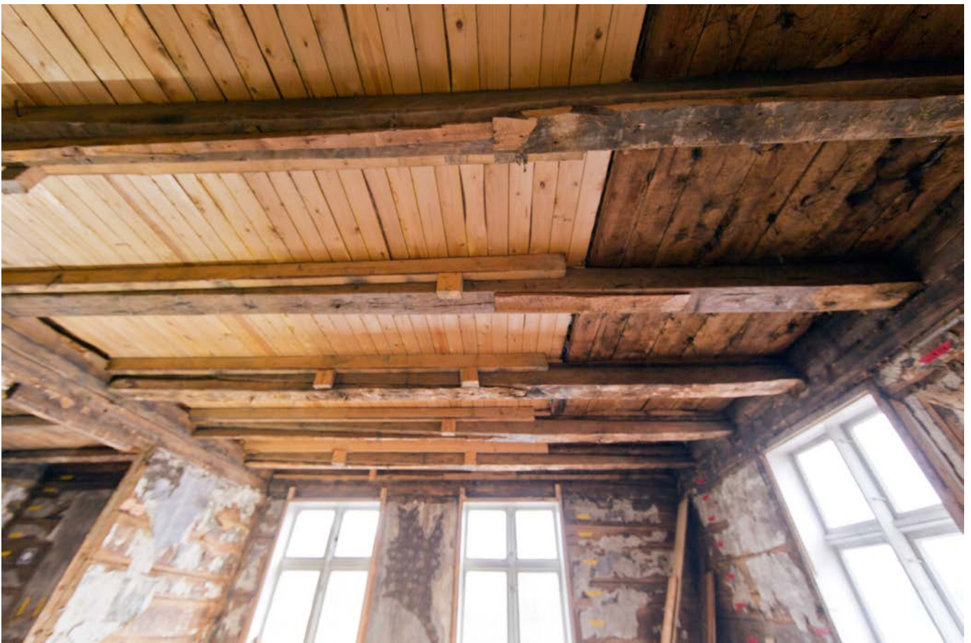
Under: Bjelkehimlingen sett fra øst mot vest.
