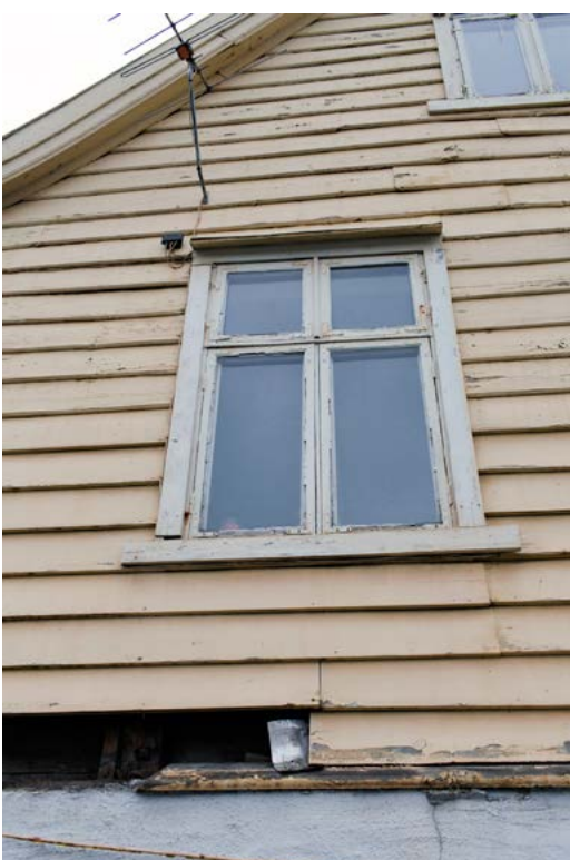
Vindu fra 1830-årene. Vestfasaden
