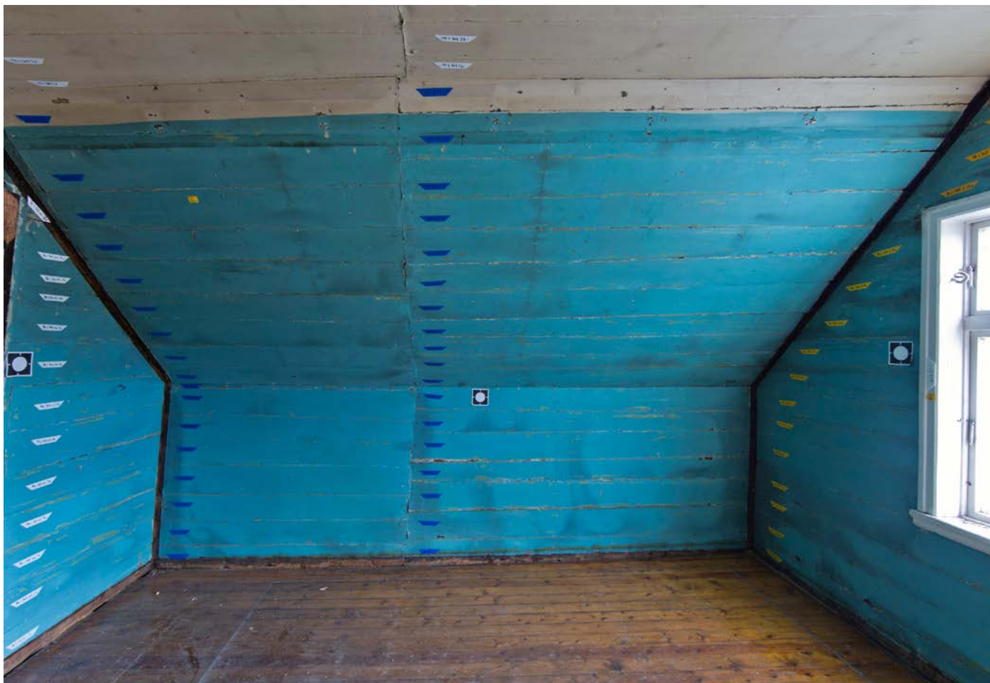
Over: Avdekket. Fra nord mot syd.
