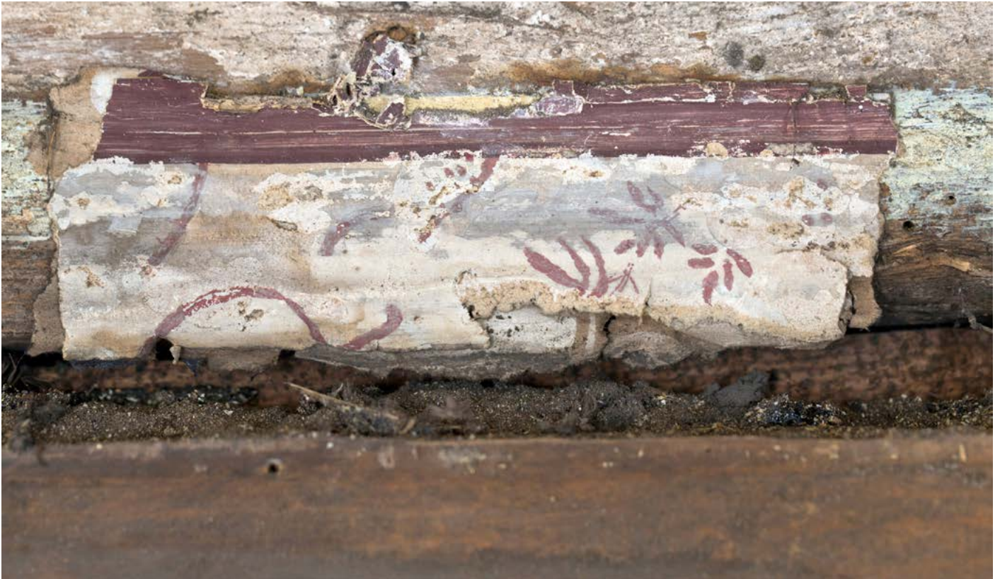
Over og under: tapetrester i overkant av brannmuren. Samsvarer med rester andre steder i rommet.
