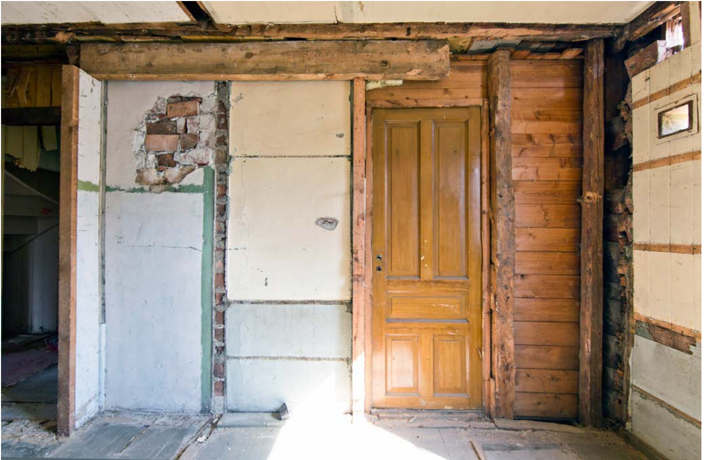
Over: Østvegg med avdekket ådret dør fra 1878 da 206 ble kjøkken tilordnet rommene påbygget mot øst.
