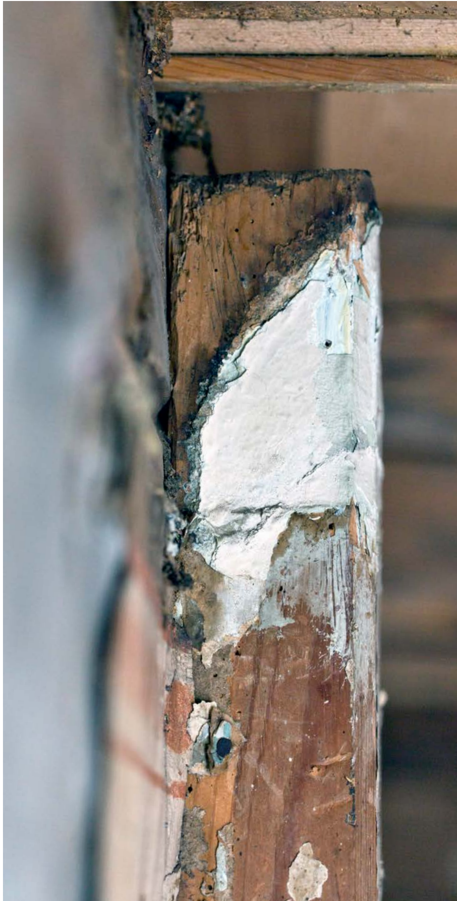
Negativspor etter stor hulkil taklist på strekkfisk nordvegg fra 1830-årene. Himlingsbordene fra samme tid er her tatt ned.
