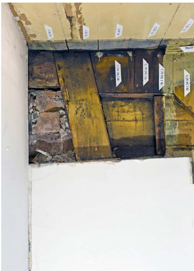
Over: Fra syd mot nord. Under: Gammel skråstiver antagelig vinkel etter gruekappen
