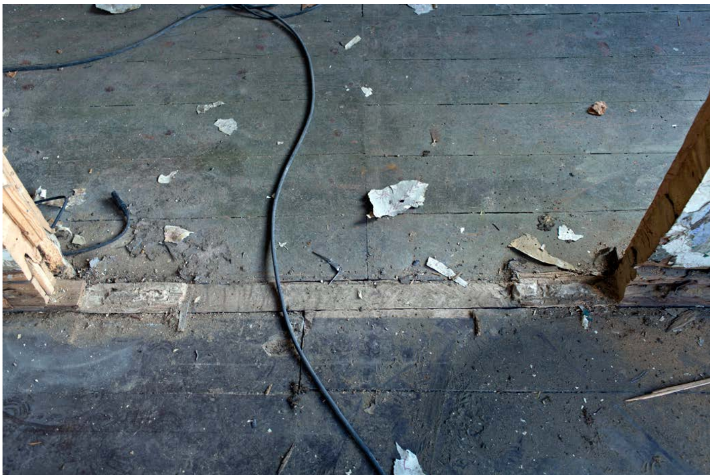
Under: Døråpning mot gulvet.
