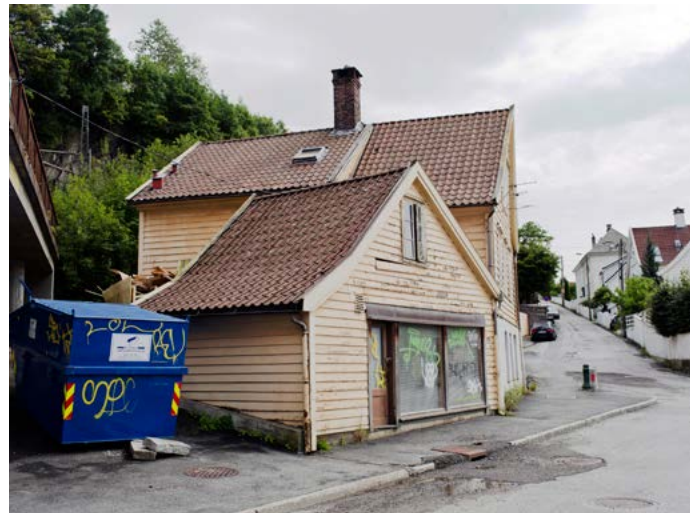
Tilbygget med forretningslokale
