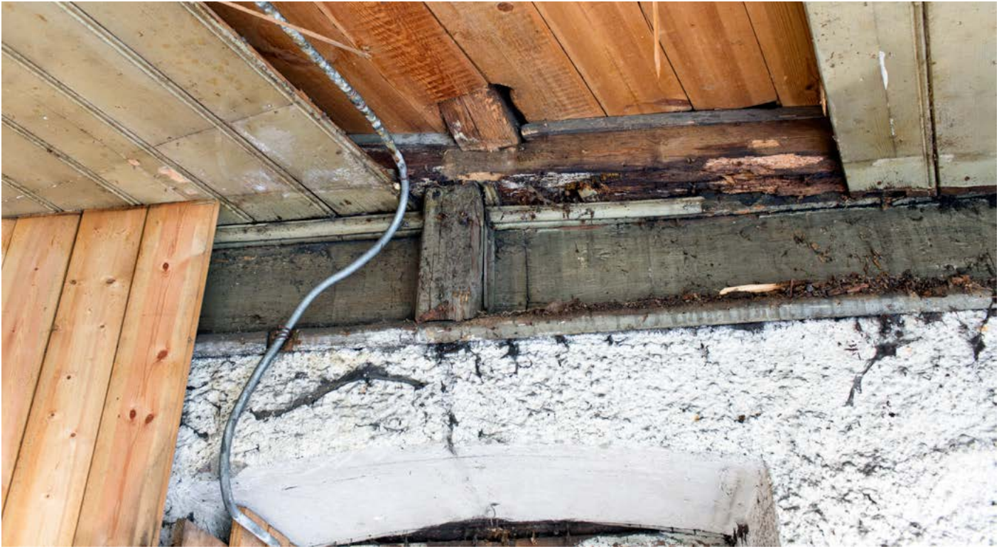
Over: Avdekket grunnmur, ytterpanel og sokkellist hovedhusets nordside.
