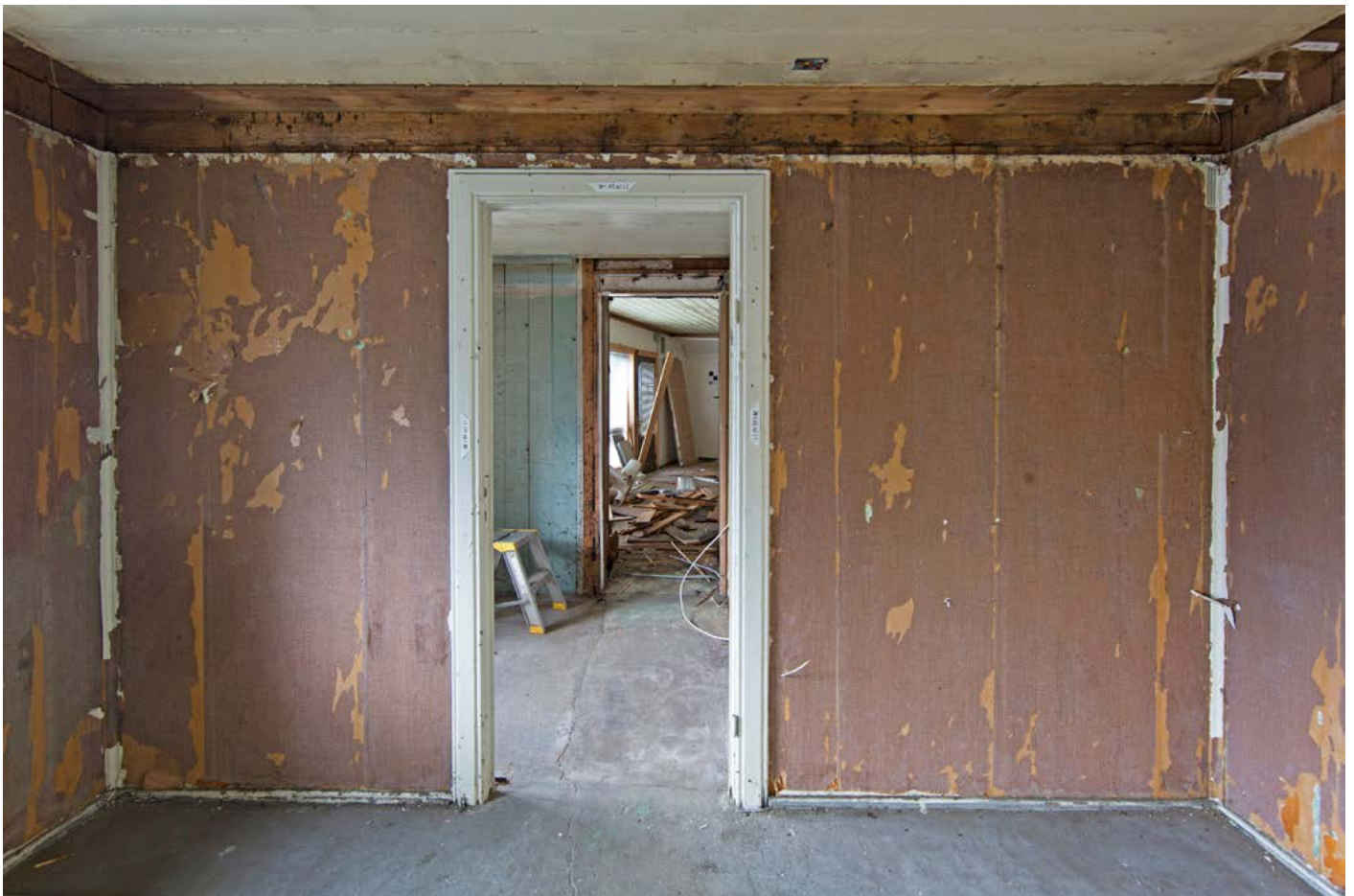
Under: Vegg mot nord etter avdekking.
