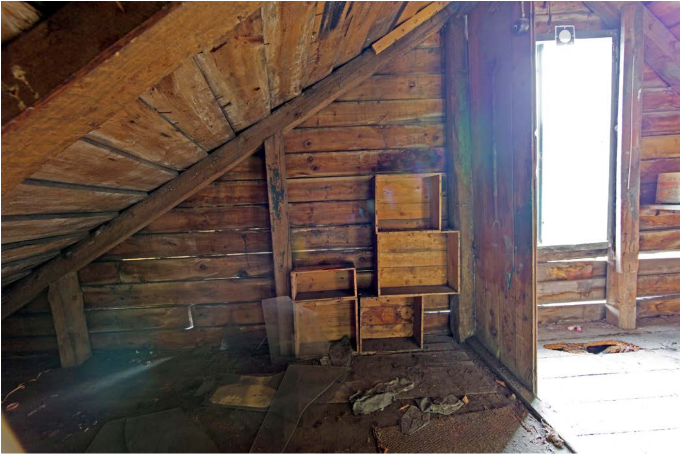
Over: Avdelt kott/oppbevaringsrom i sydvestre hjørne.
