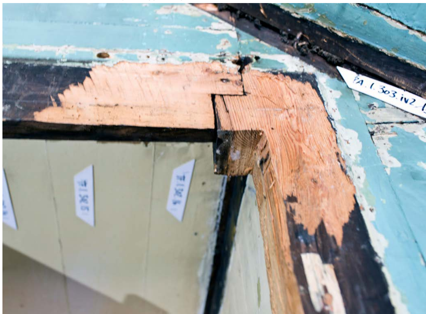
Under: Søndre hjørne av åpningen hugget for gerikt.
