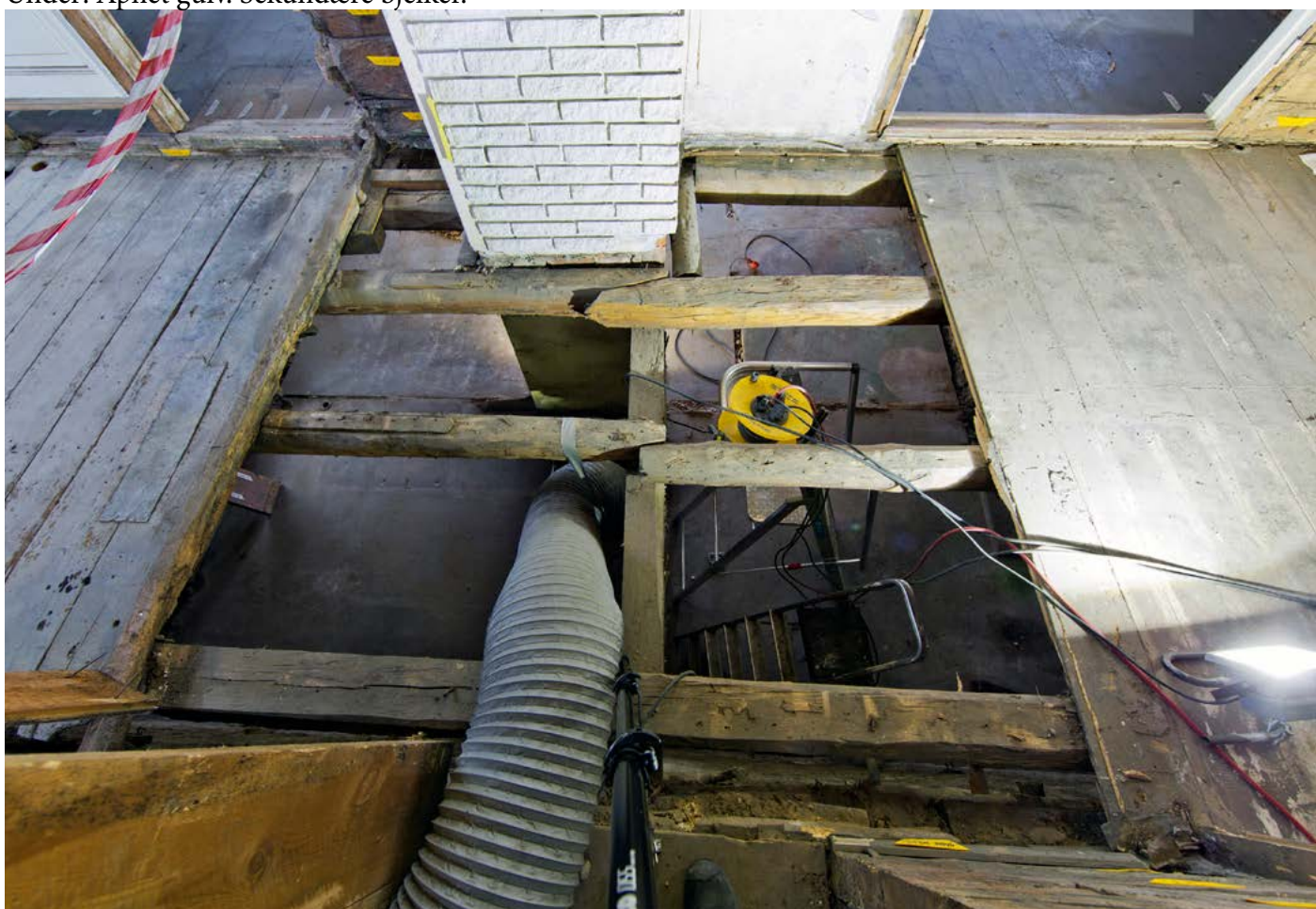
Under: Åpnet gulv. Sekundære bjelker.
