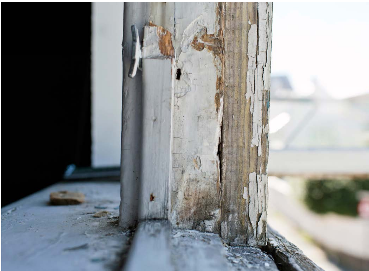
Over: Vindu fra 1830-årene med sekundær midtpostfals i karm. Påslått stykke tre. Under: Profiler og losholt.
