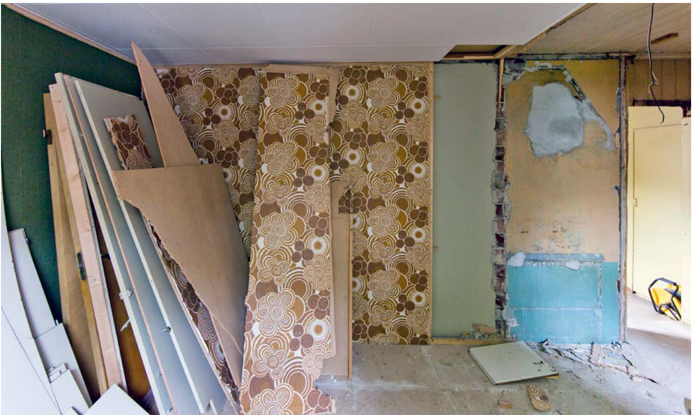
Under: Rom 209 før avdekking. Vegg mot vest. Rom 207 til høyre for brannmuren.
