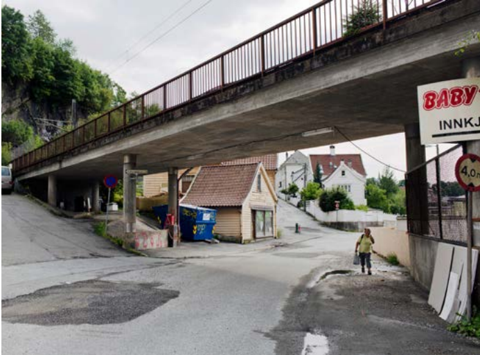
Kalfarveien syddover. Søndre Fløen bak jernbanebroen.
