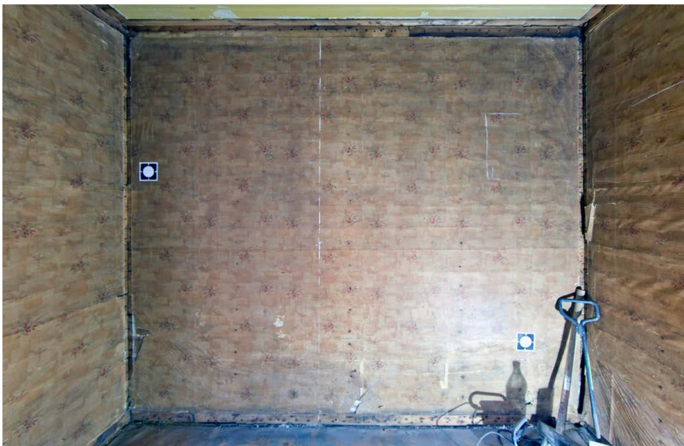
Over: Vegg mot syd etter avdekking.
