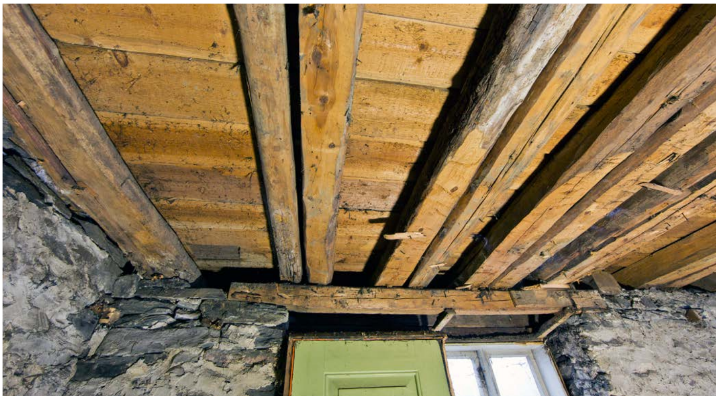
Over: Søndre del av bjelkelag under kjøkken 203 og kammer 206.
