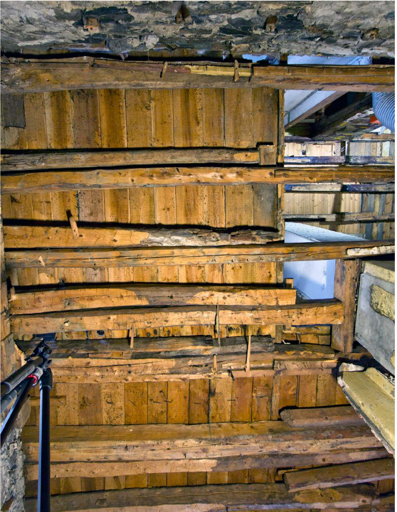
Bjelkelag under søndre del av kjøkken 203 samt kammers 206. Opprinnelige bjelker bevart, men forsterket med nye.
