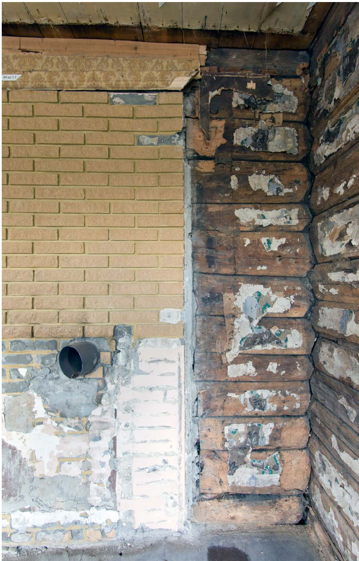
Vegg mot øst, søndre del, avdekket. Brannmur til venstre. Opprinnelig del av gruens bakvegg.
