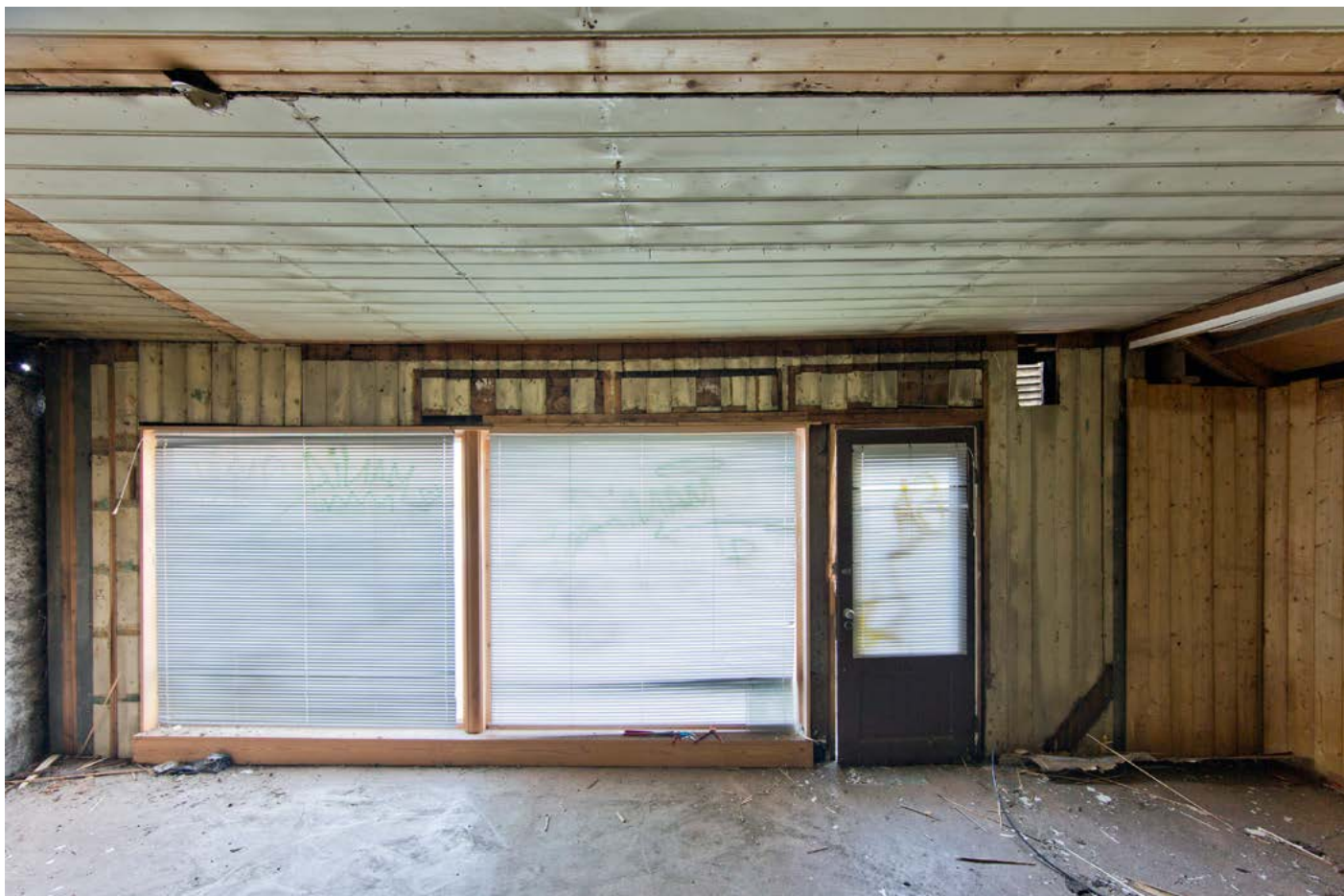
Over: Vestveggen mot gaten. Avdekket.
