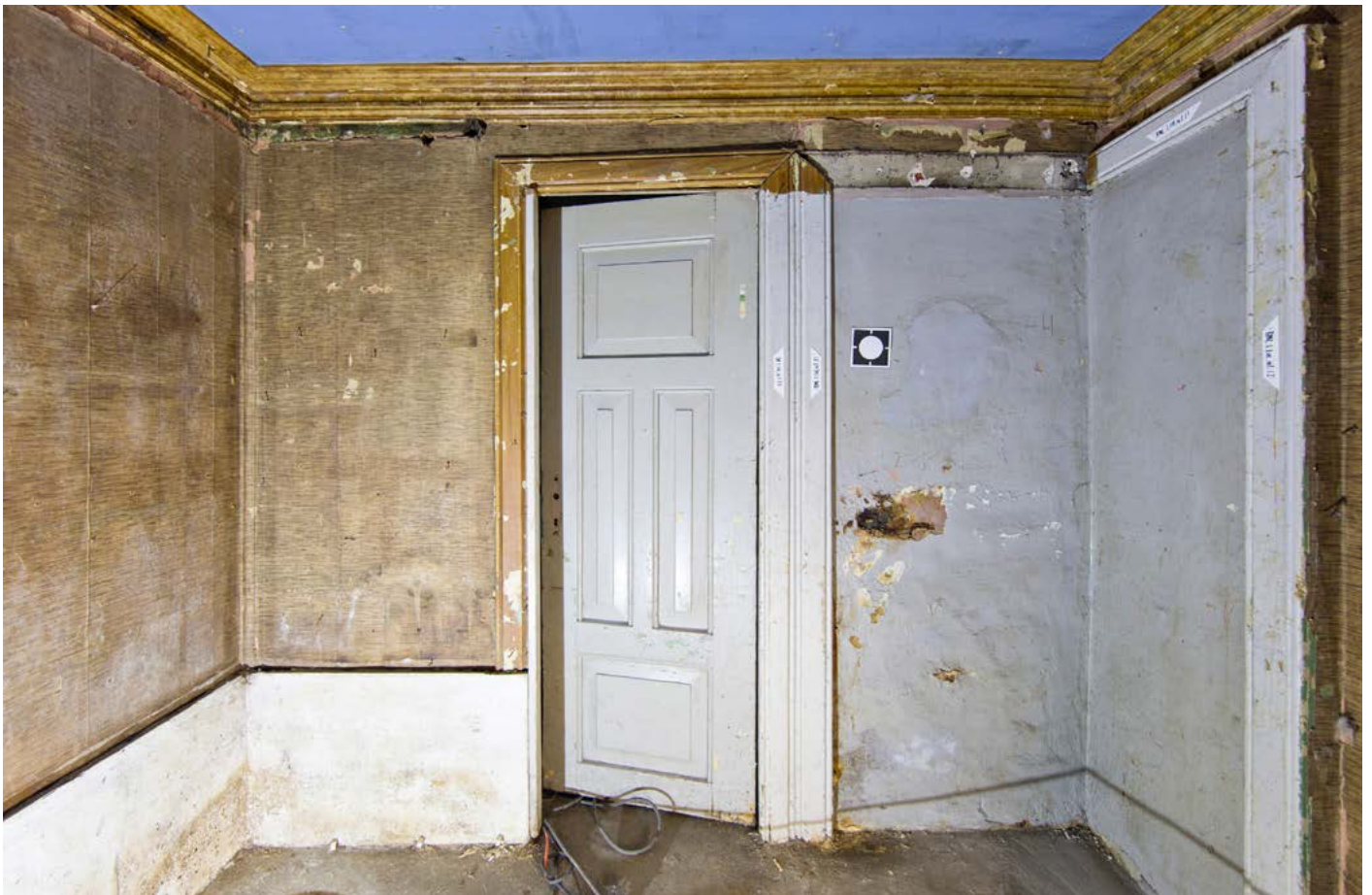
Under: Vegg mot syd. Avdekket.
