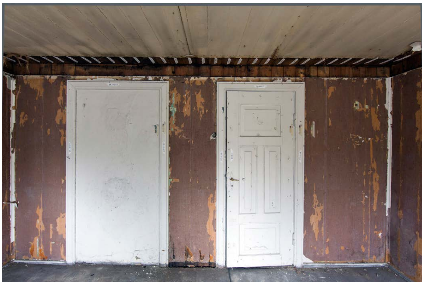
Under. Vegg mot øst etter avdekking.
