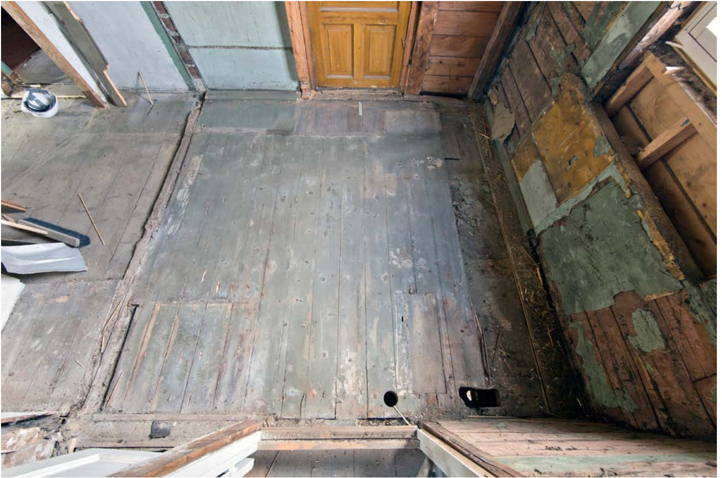
Over: Gulvet under linoleumslagene sett fra vest mot øst. Sekundære gulvbord fjernet.
