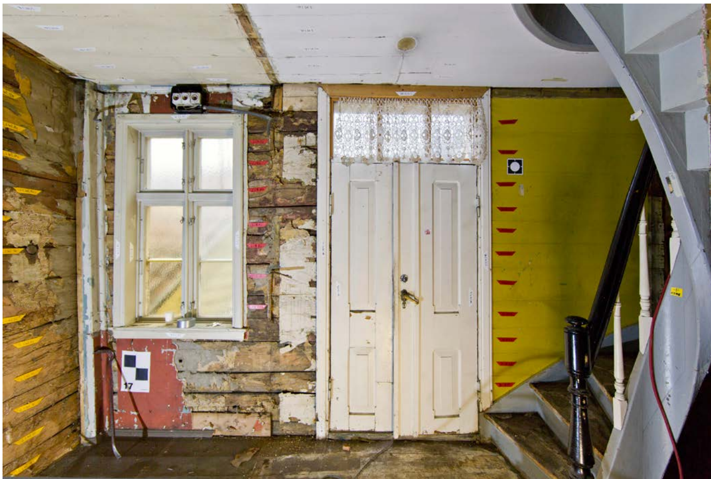
Over: Vegg mot nord etter fjerning av sekundære lettvegger og overflater.
