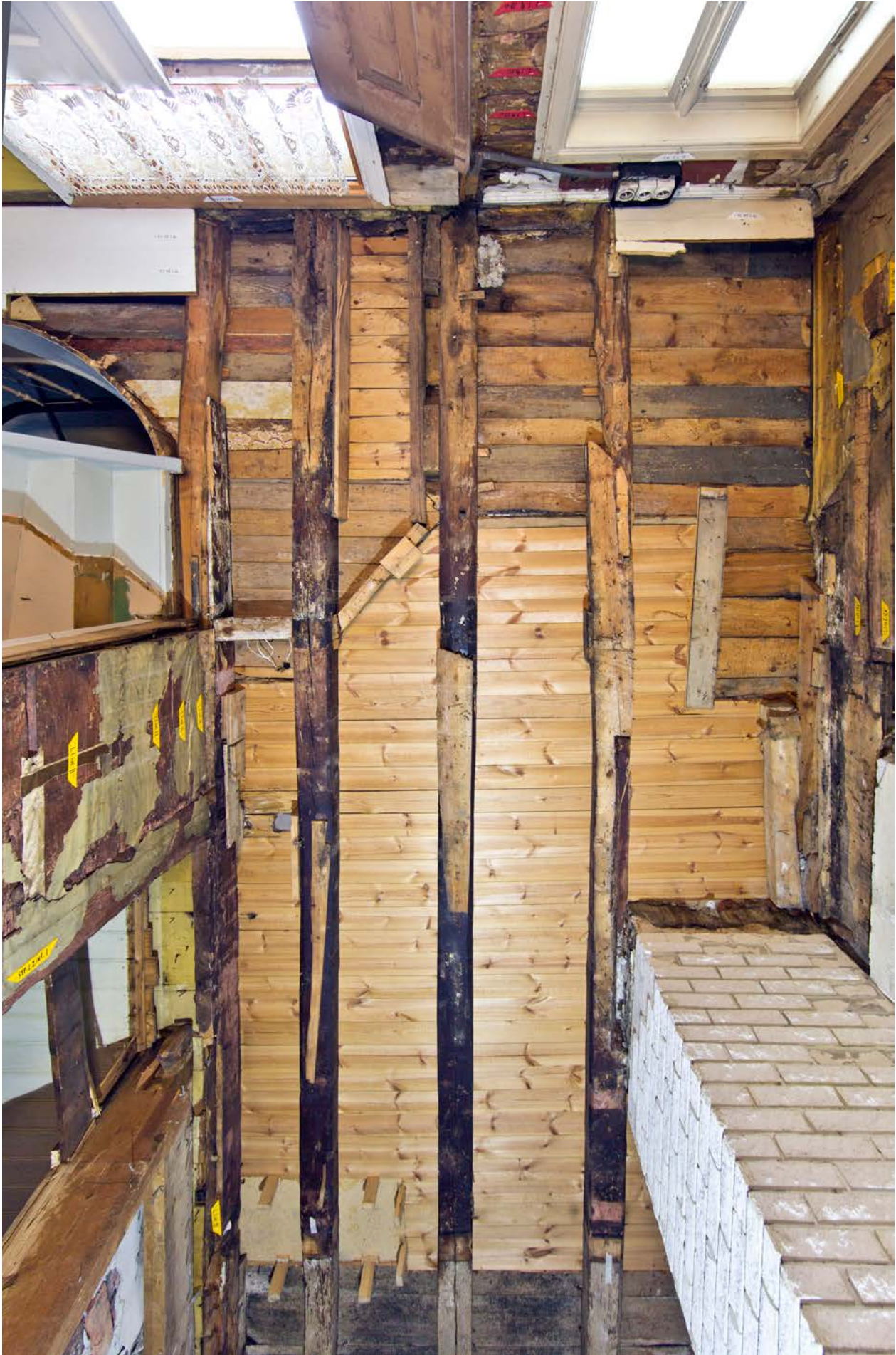
Over. Opprinnelig bjelkehimling uten underforede himlingsbord. Legg merke til påskjøting i øvre hjørne til høyre (nordvest): Spor etter åpning for opprinnelig loftstrapp. Alle opprinnelige himlingsbord er skiftet ut med unntak av partiet nederst (syd) mot kammerset 206. Ned er syd.
