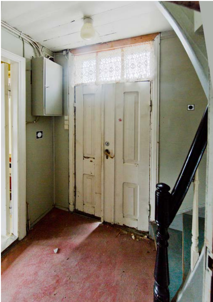
Over: Hovedinngangsdøren mot nord. Antagelig opprinnelig dør fra 1878.
