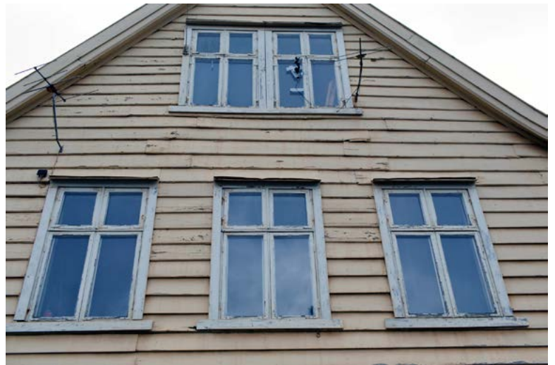
Vinduer på vestfasaden
