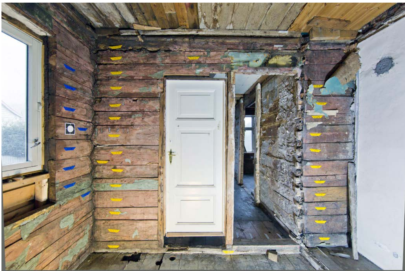
Over: Vegg mot vest avdekket. Opprinnelig kammers. Begge døråpninger er sekundære. Under: Gulv. Spor etter benker i ytterkant av linoleum. Døren til venstre til 209 i siste periode blendet.
