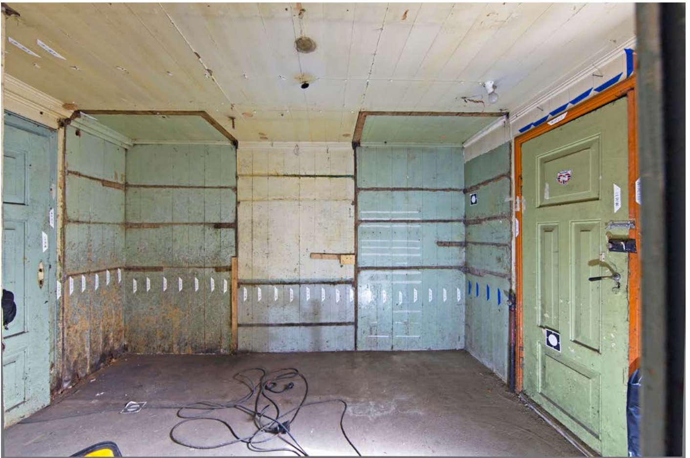
Over: Kjøkkenvegg mot øst. Spor etter innredning. Benk og to skap.
