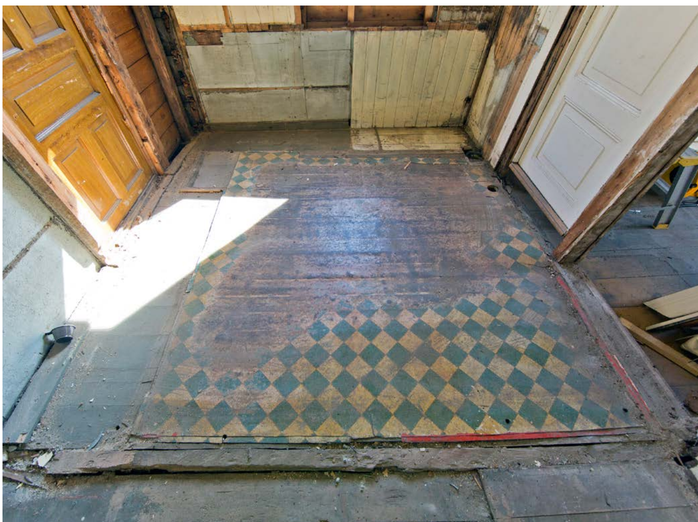
Over: Vegg mot vest avdekket. Opprinnelig kammers. Begge døråpninger er sekundære. Under: Gulv. Spor etter benker i ytterkant av linoleum. Døren til venstre til 209 i siste periode blendet.
